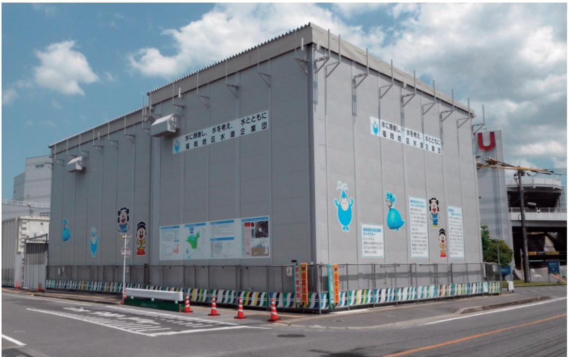
写真3 シールド工事の発進立坑上屋
