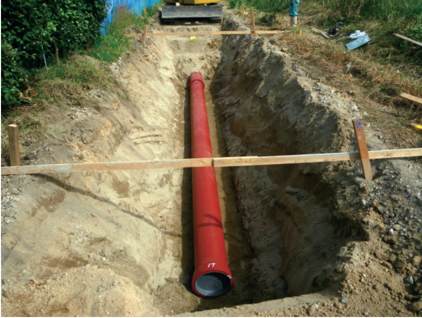
写真2 ALW形管の施工状況
