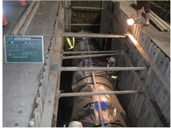
写真2-2 呼び径1200 S形 乙切管2.25m+継ぎ輪配管状況
