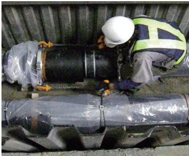
写真2 継手施工状況
