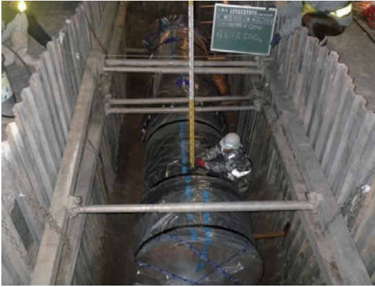
写真2-1 呼び径1200 S形 甲切管1.5m 配管状況
