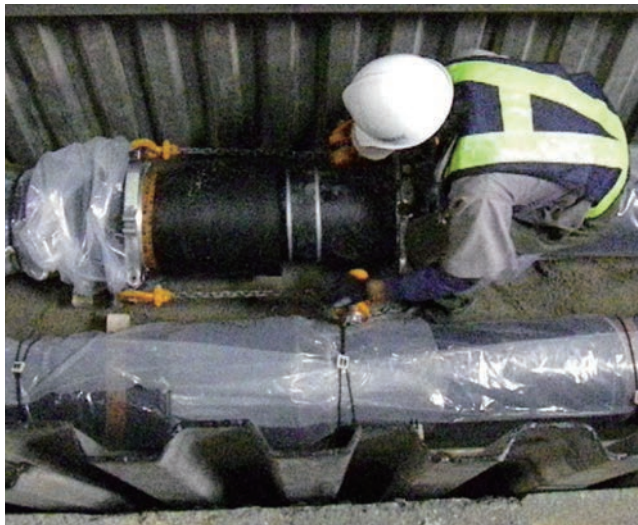
写真2 継手施工状況
