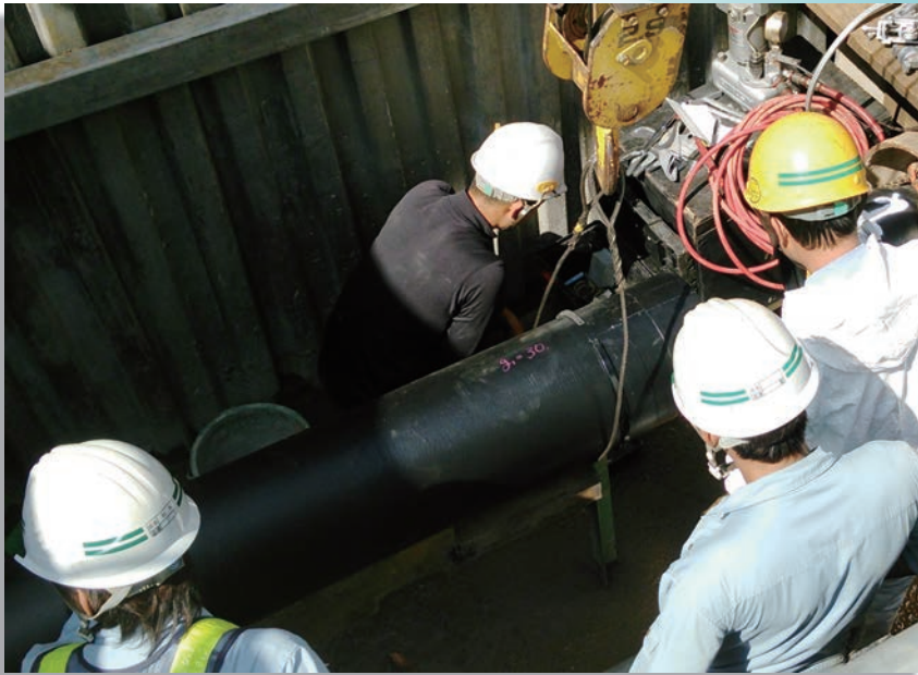
京都市上下水道局 PN 形 呼び径 300
