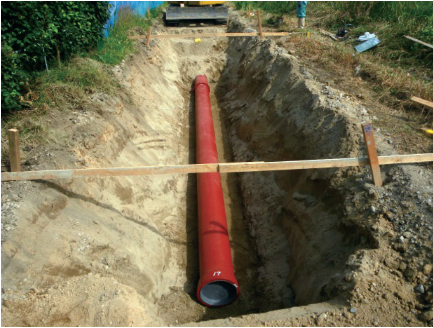
写真2 ALW形管の施工状況
