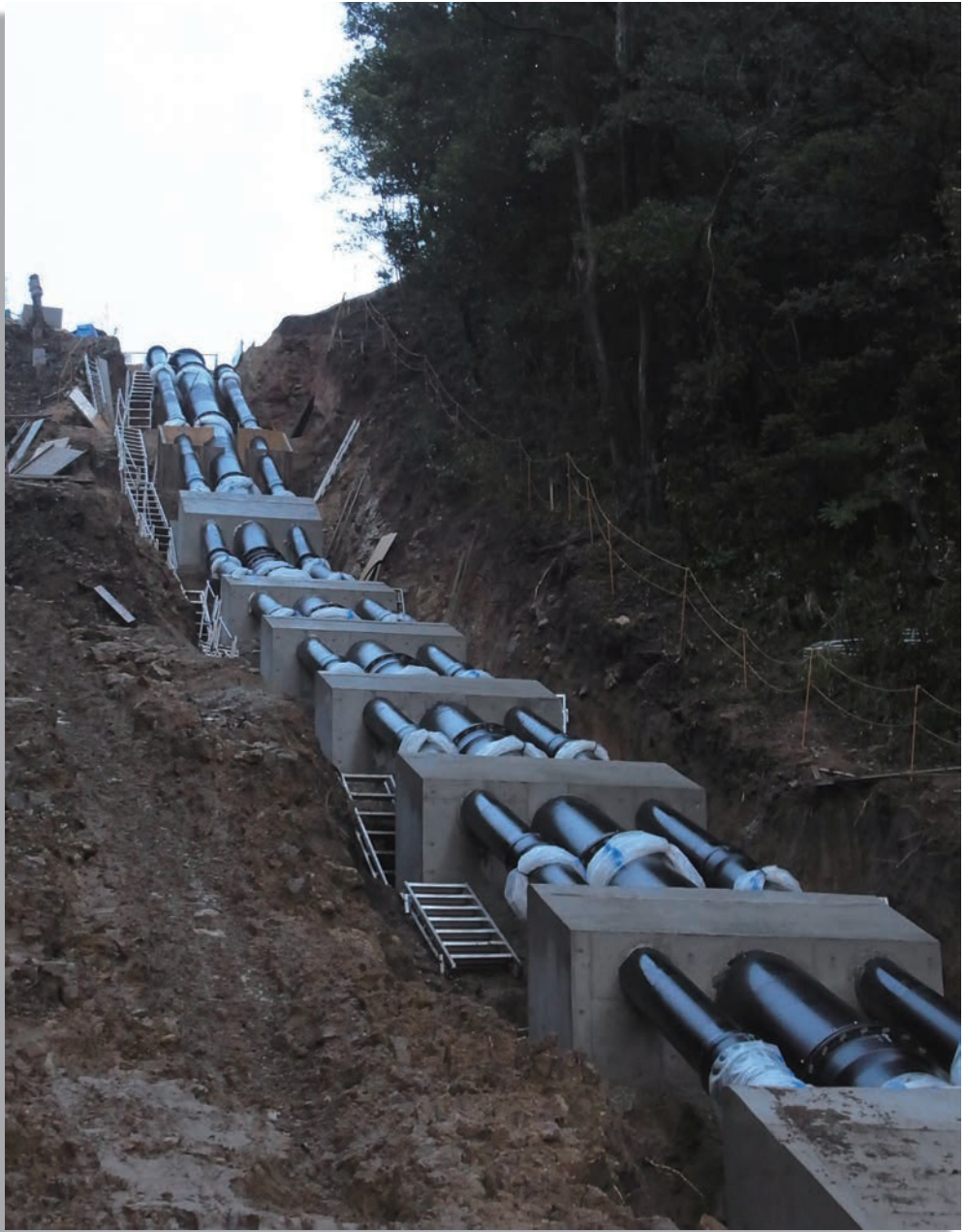
鳥取県 米子市水道局 NS 形 呼び径 800・400 (2条)
