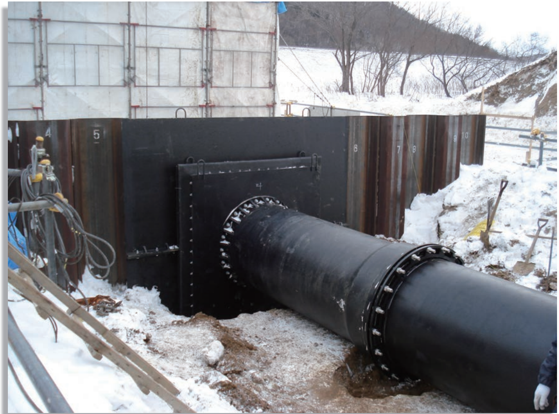
北海道渡島総合振興局 函館建設管理部 NS形 呼び径 1000 (河川樋管)
