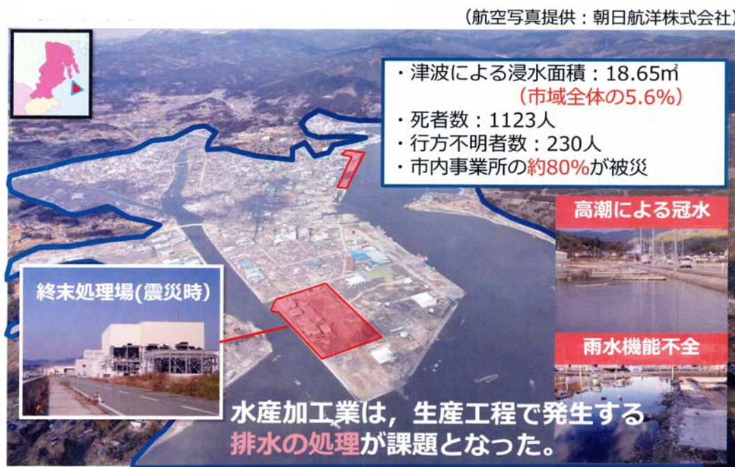
図1 被害状況について
