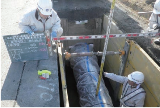
写真2 土被り確認状況
