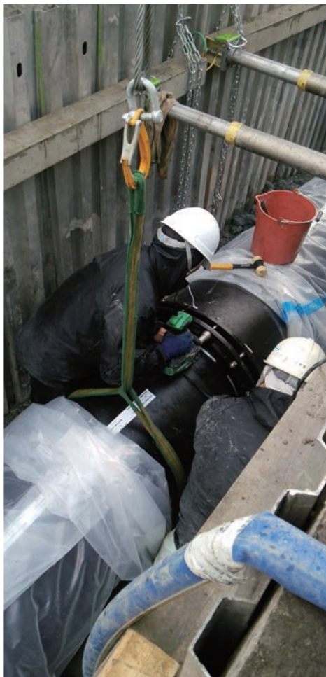
写真3 継手施工状況
