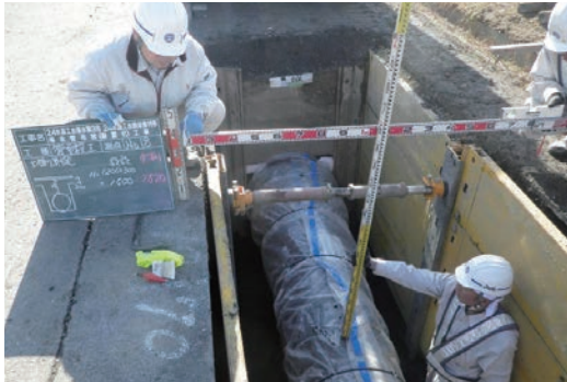
写真2 土被り確認状況
