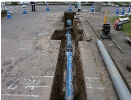
●配水管の耐震化
