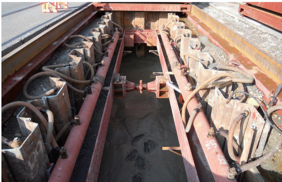
写真4 ウエルポイント施工状況
