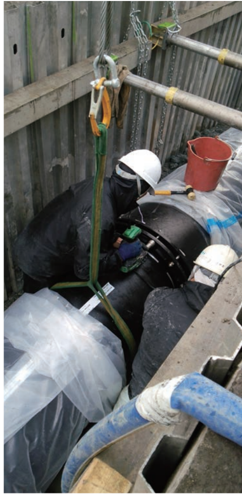
写真3 継手施工状況
