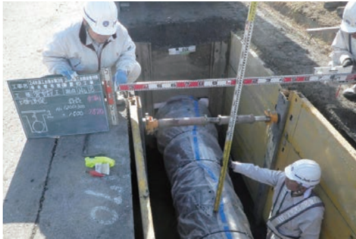
写真2 土被り確認状況
