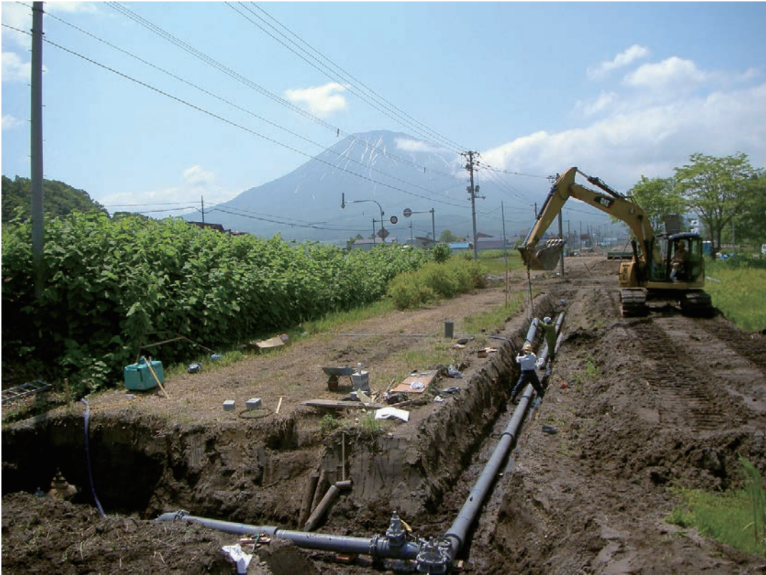
北海道・倶知安町水道課 フツチャン 背景:羊蹄山(蝦夷富士) GX形 呼び径200
