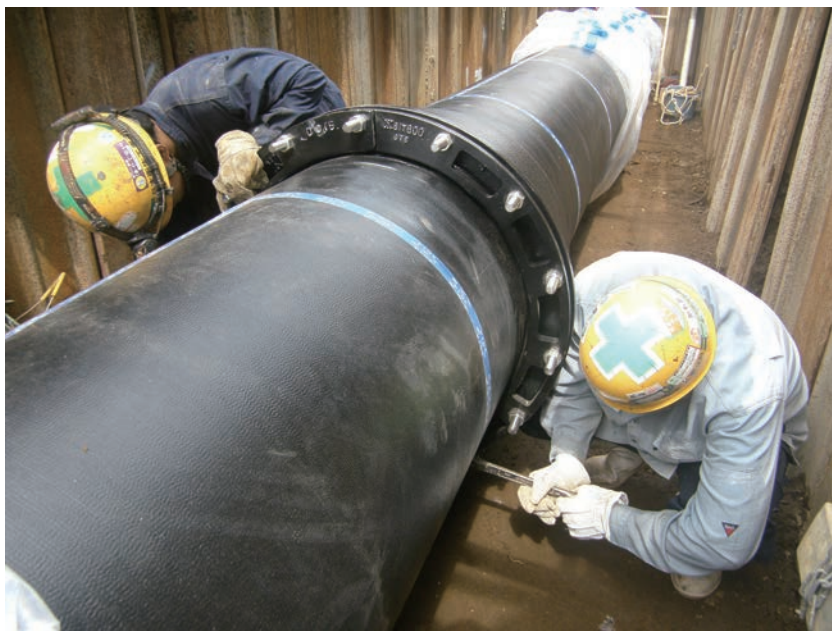
埼玉県・狭山市上下水道部 NS形 呼び径 600
