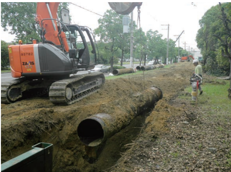
写真5 管撤去状況
