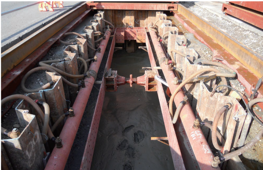
写真4 ウエルポイント施工状況
