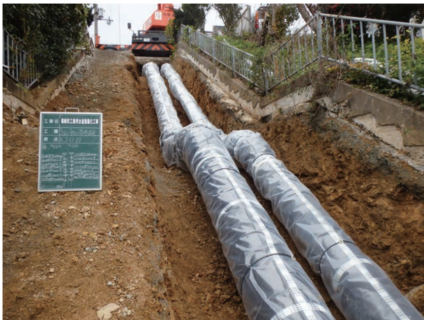
兵庫県・福崎町上下水道課 NS形 呼び径350・NS形 呼び径450
