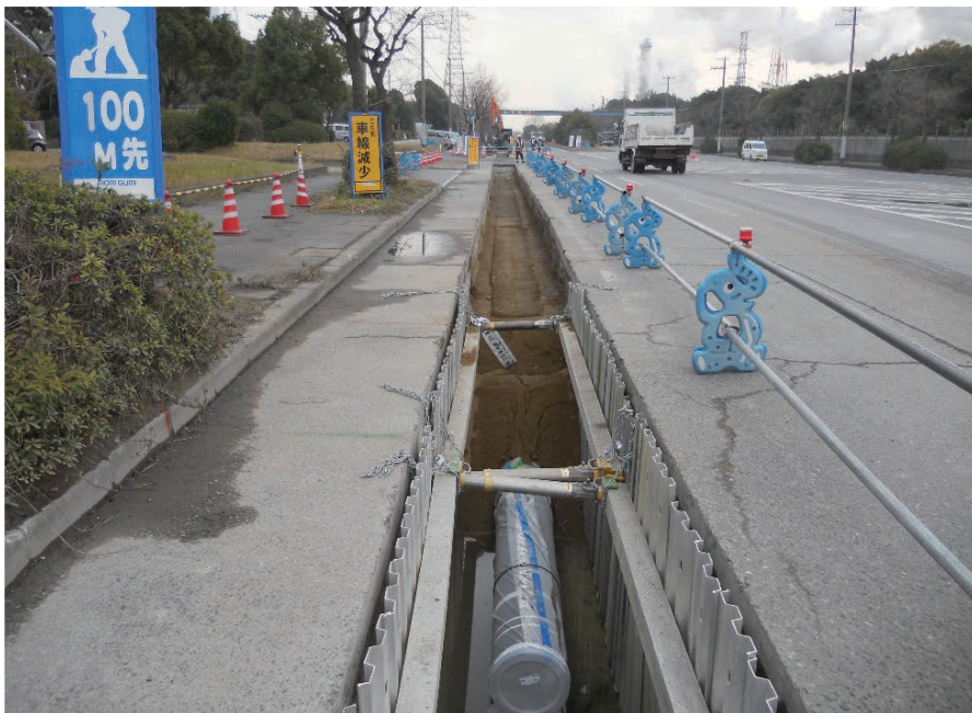
写真1 現場規制状況
