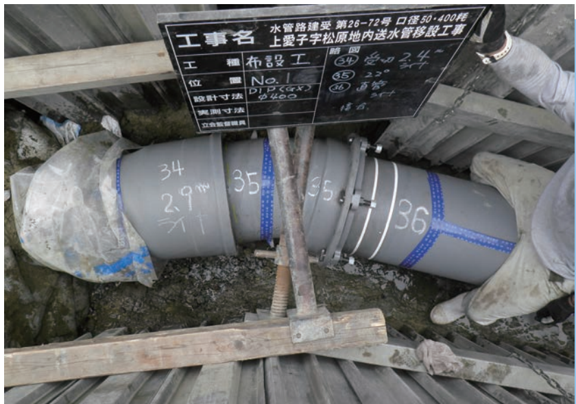
仙台市水道局 GX形 呼び径400
