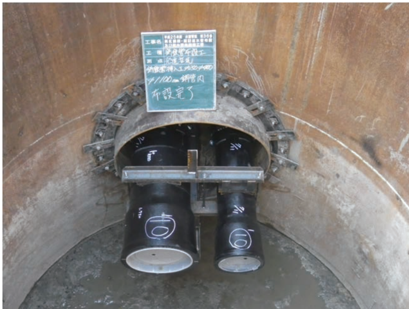
静岡市上下水道局 NS形 呼び径400・NS形 呼び径150
