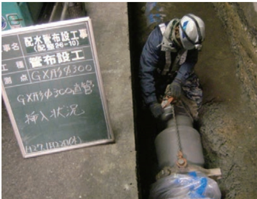
写真1 (直管の施工状況)
