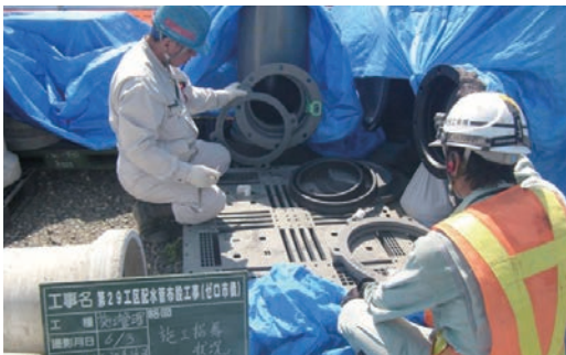
写真1 呼び径400 鉄管メーカーによる接合指導
