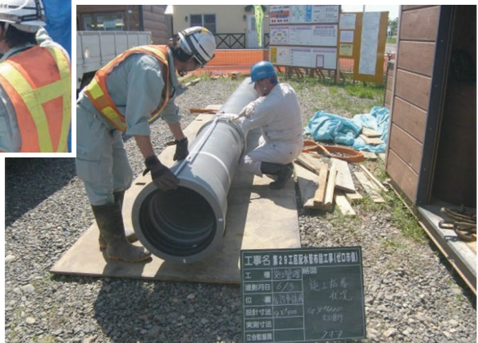
写真2 呼び径400 接合指導状況
