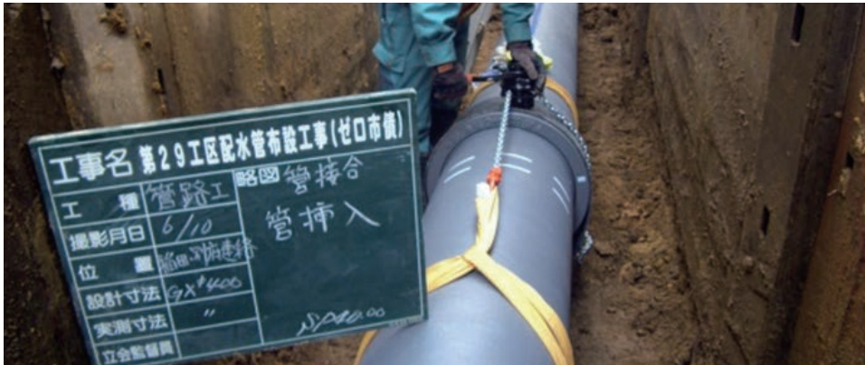
写真3 呼び径400 管(直管)接合(管挿入)状況
