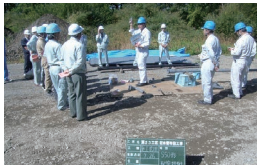
写真7 施工状況 呼び径50 メーカによる接合指導
