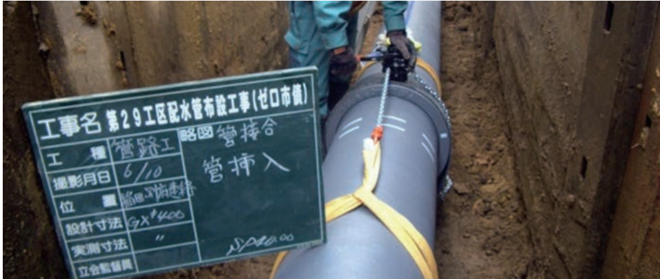
写真3 呼び径400 管(直管)接合(管挿入)状況
