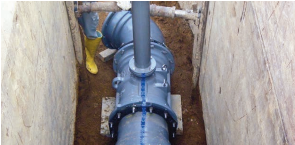
写真5 布設状況 直管→仕切弁→異形管
