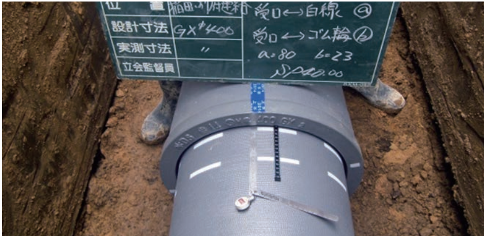
写真4 呼び径400 接合確認
