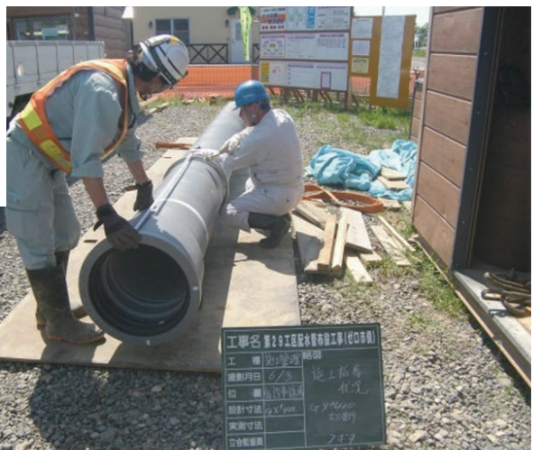
写真2 呼び径400 接合指導状況
