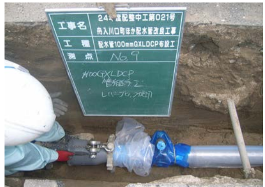
●配水管布設工事 GX形 呼び径100
