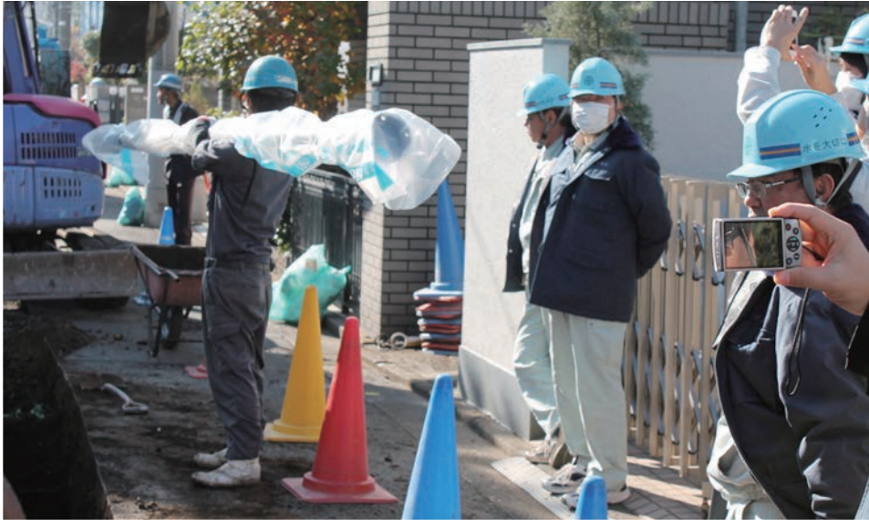
写真2 試験施工見学会写真
