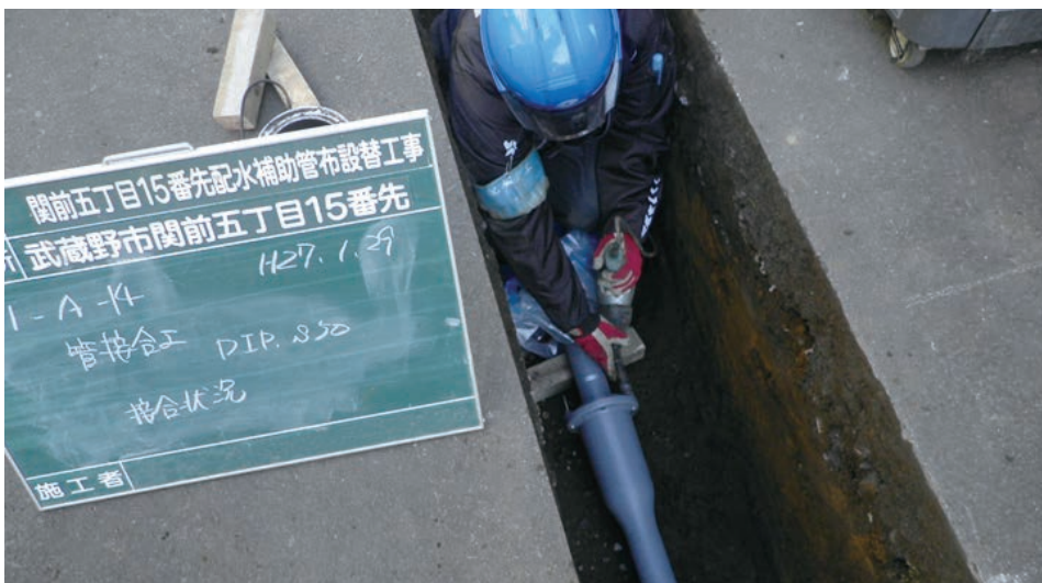
写真3 S50形施工写真
