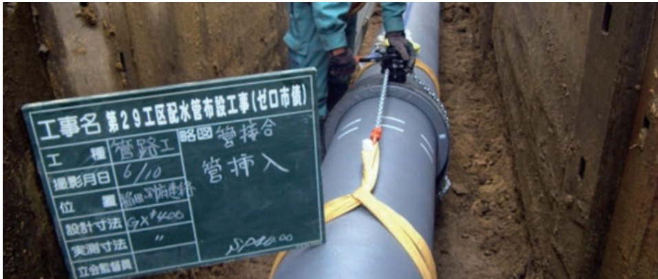
写真3 呼び径400 管(直管)接合(管挿入)状況
