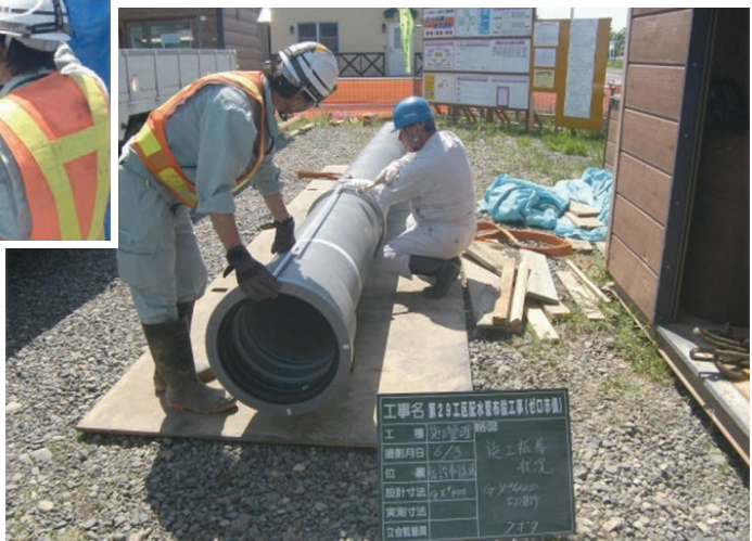
写真2 呼び径400 接合指導状況
