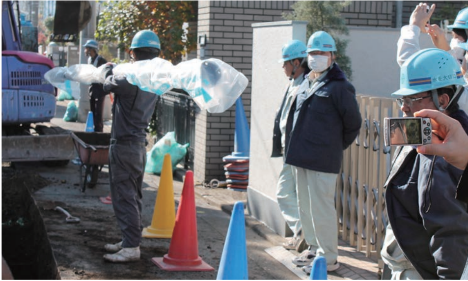
写真2 試験施工見学会写真
