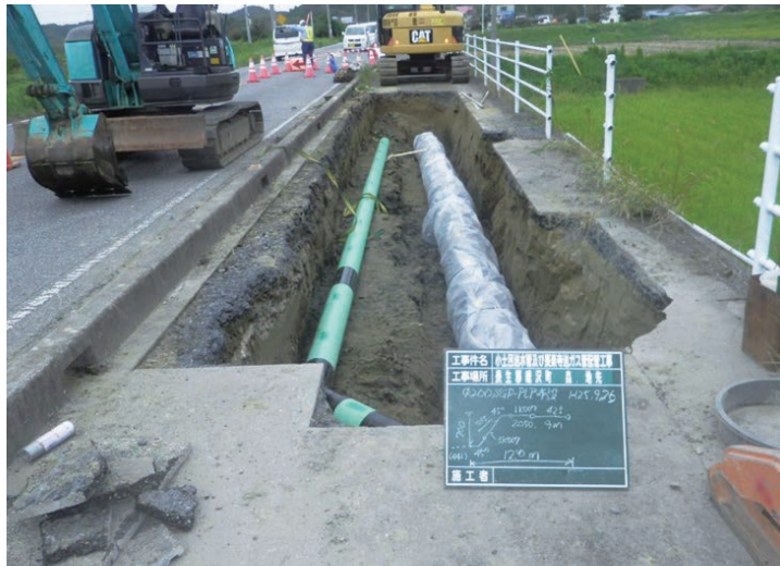
写真2 管布設状況
