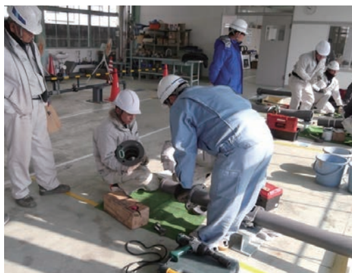
写真4(配管技能講習会)
