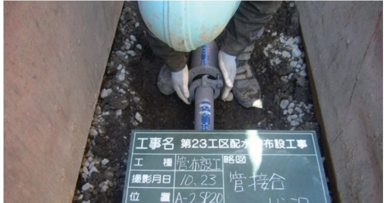
写真8 呼び径50 管接合(挿入)状況
