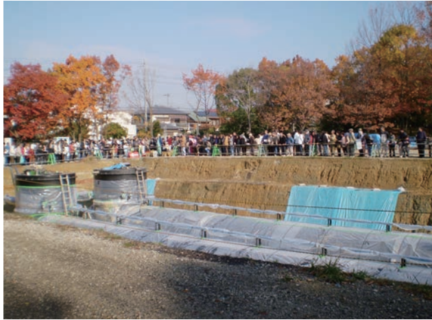
写真2 大容量貯水槽の工事見学会
