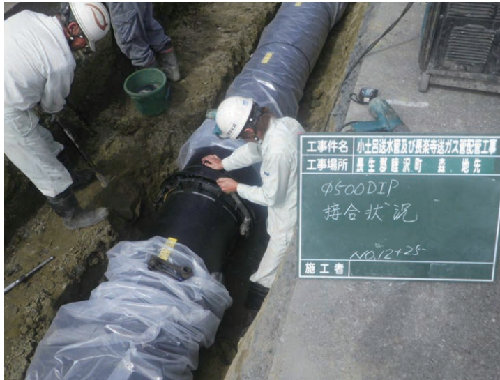
写真1 K形継手接合状況
