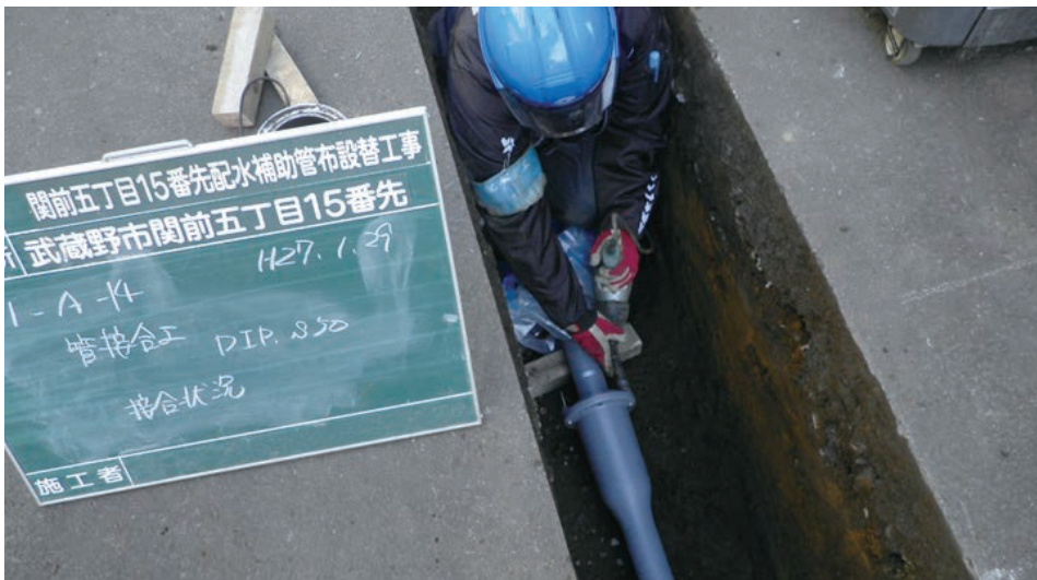
写真3 S50形施工写真
