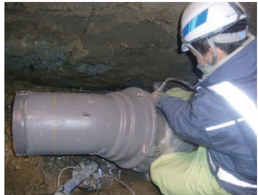
写真2 (異形管の施工状況)
