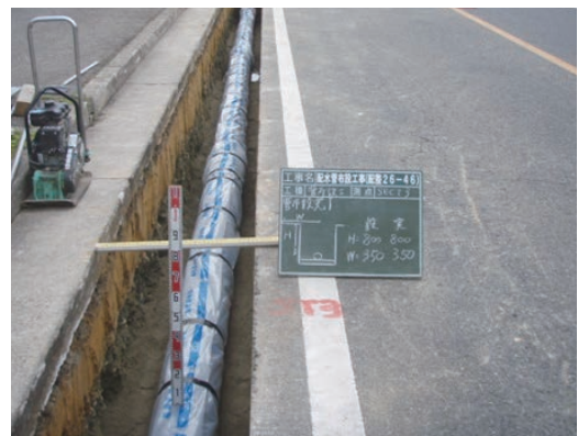
写真3 (直管の施工状況)
