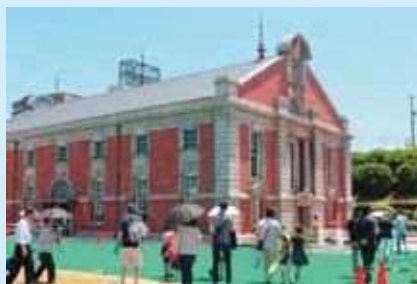
旧第一ポンプ所
