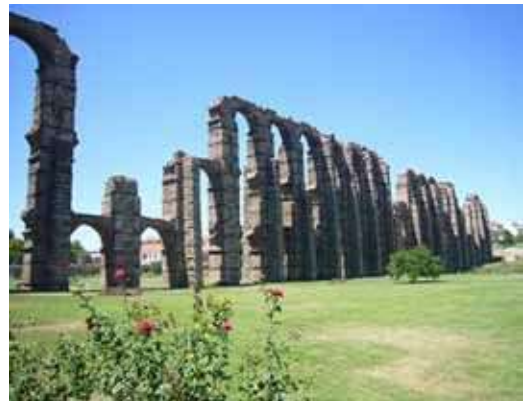
●写真1 Los Milagros水道橋(スペイン)
