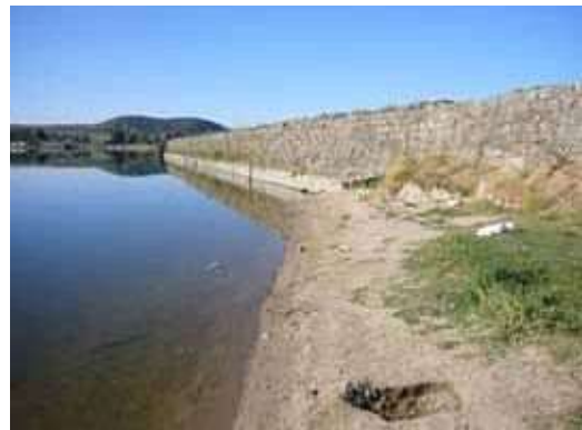
●写真2 Proserpina Dam(スペイン)
