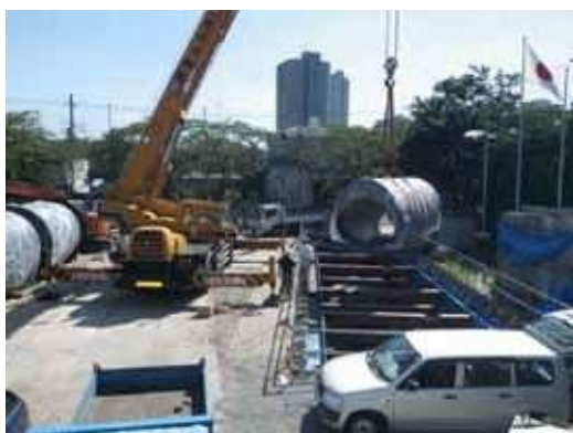
写真4 貯水タンク（ダクトイル製）布設状況
