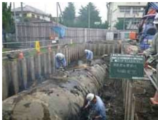
写真3 既設貯水タンク（鋼製）撤去状況
