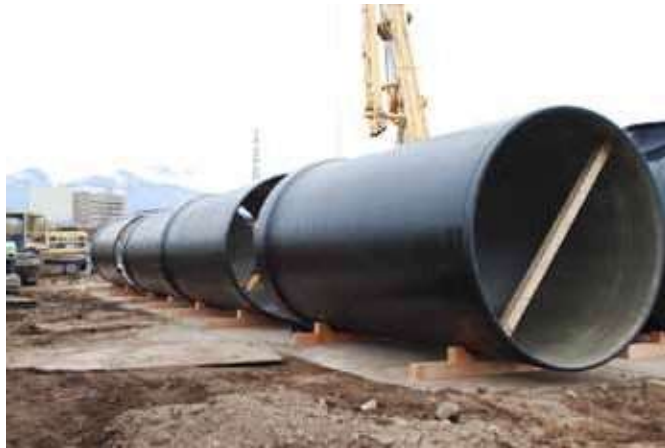
写真3 耐震性貯水槽搬入
