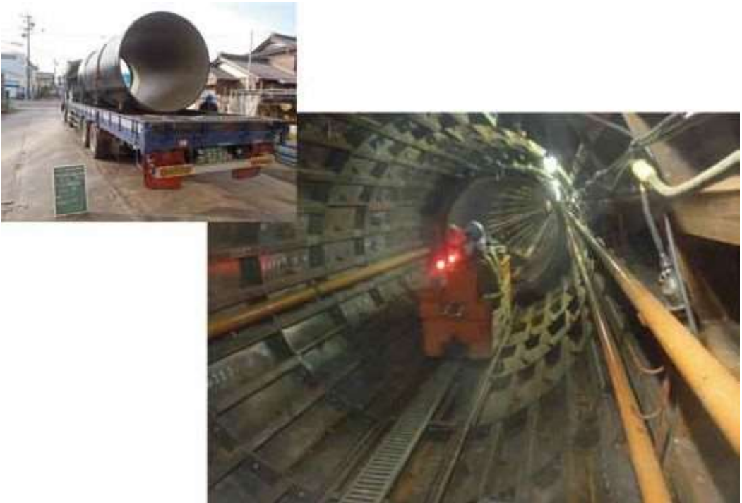
写真2 US形ダクタイル鉄管搬入状況
