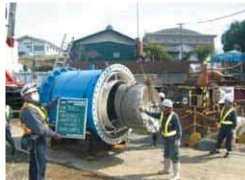
写真4 コンクリート切片引抜状況
