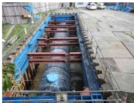
写真5 貯水タンク（ダクトイル製）設置状況
