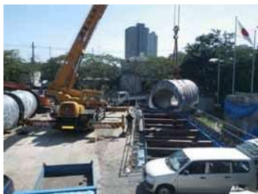
写真4 貯水タンク（ダクトイル製）布設状況
