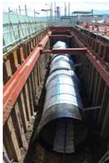
写真4 耐震性貯水槽設置
