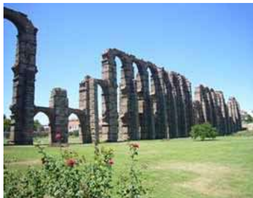
●写真1 Los Milagros水道橋(スペイン)
