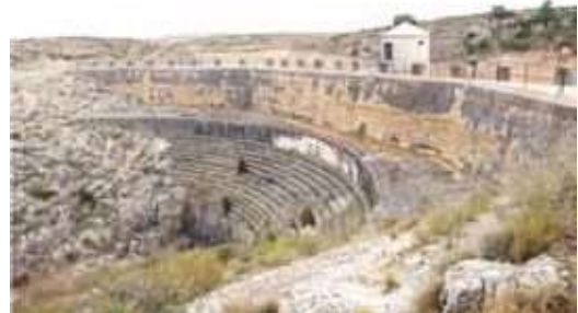
●写真3 Almansa Dam (スペイン)
