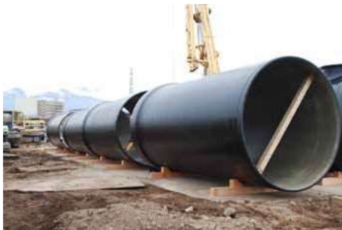
写真3 耐震性貯水槽搬入
