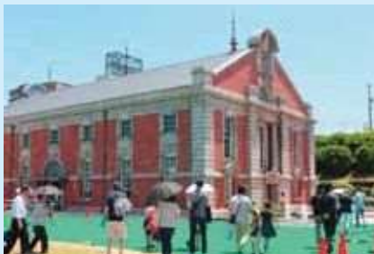
旧第一ポンプ所
