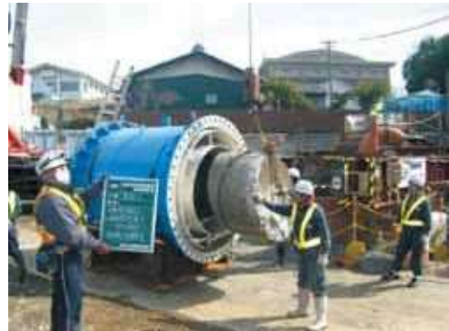
写真4 コンクリート切片引抜状況
