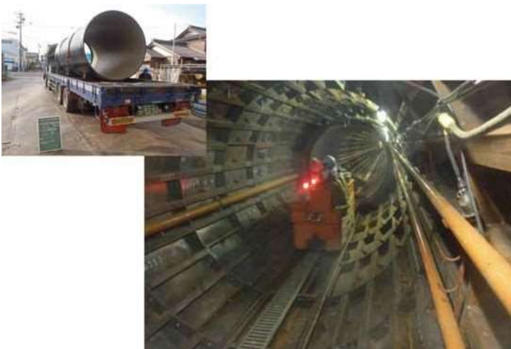
写真2 US形ダクトイル鉄管搬入状況
