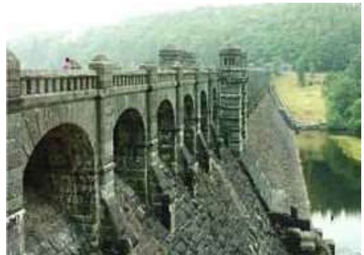
●写真5 Vyrnwy Dam (イギリス)
