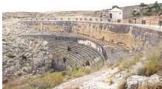
●写真3 Almansa Dam (スペイン)
