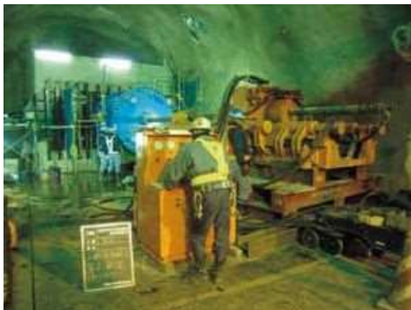
写真3 分岐部施工状況
