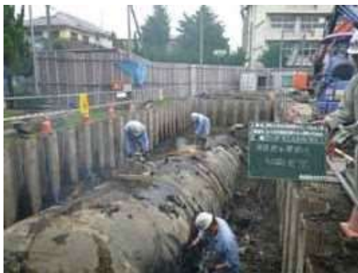
写真3 既設貯水タンク（鋼製）撤去状況
