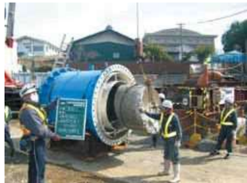
写真4 コンクリート切片引抜状況
