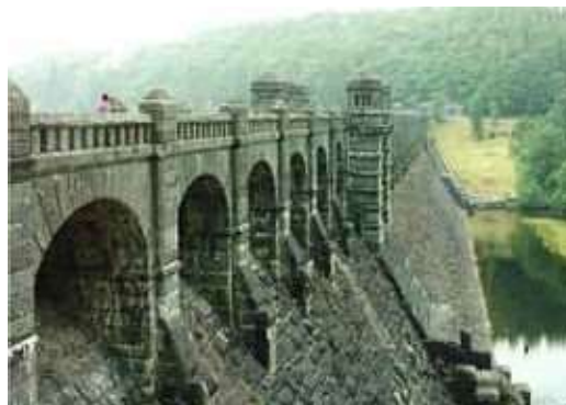
●写真5 Vyrnwy Dam (イギリス)
