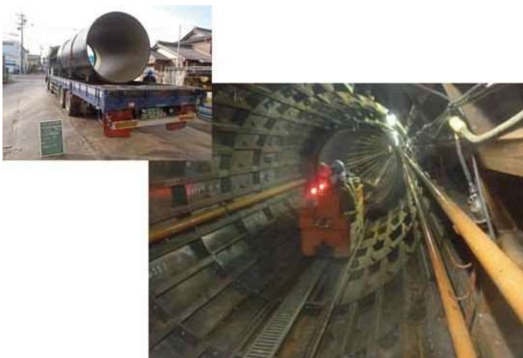
写真2 US形ダクタイル鉄管搬入状況
