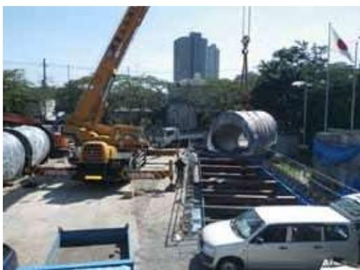
写真4 貯水タンク（ダクトイル製）布設状況
