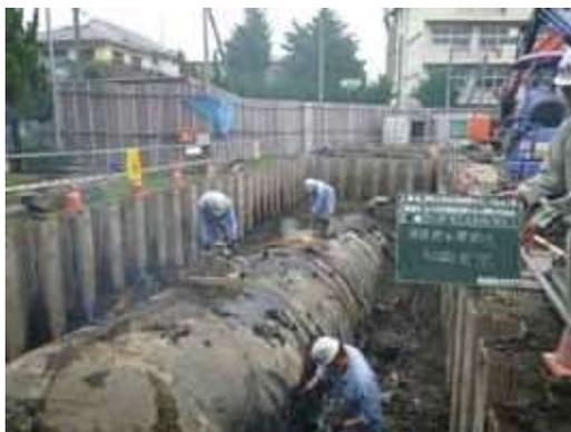
写真3 既設貯水タンク（鋼製）撤去状況
