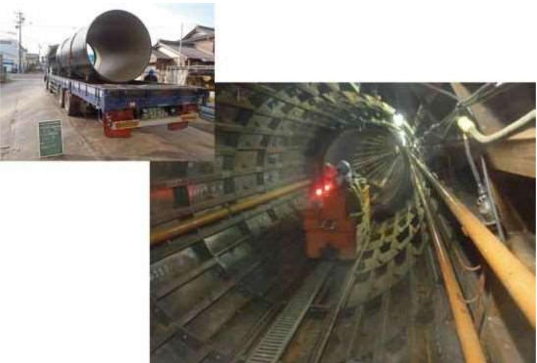
写真2 US形ダクタイル鉄管搬入状況
