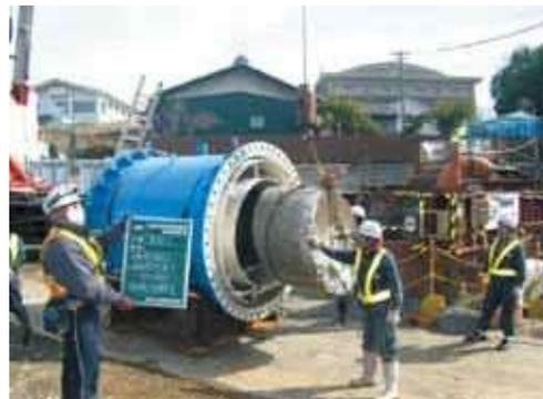
写真4 コンクリート切片引抜状況
