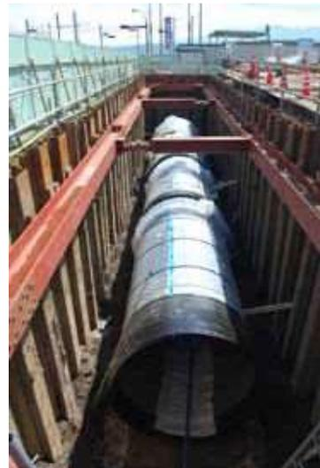
写真4 耐震性貯水槽設置
