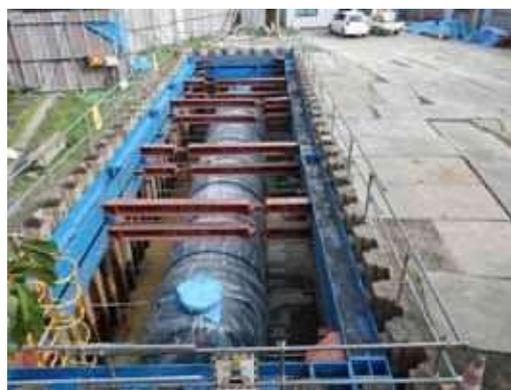
写真5 貯水タンク（ダクトイル製）設置状況
