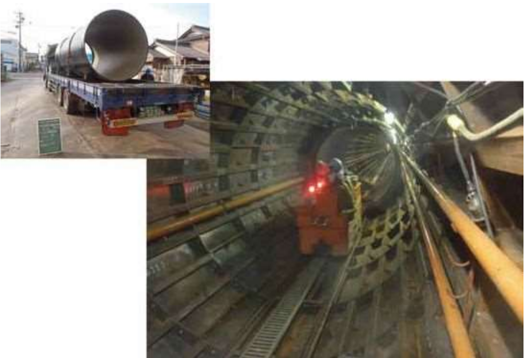
写真2 US形ダクタイル鉄管搬入状況
