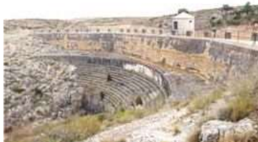
●写真3 Almansa Dam (スペイン)
