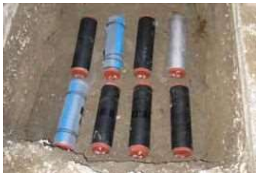
図12 海成粘土での埋設試験
