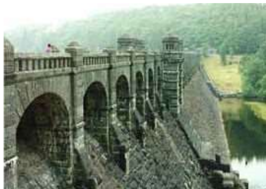
●写真5 Vyrnwy Dam (イギリス)
