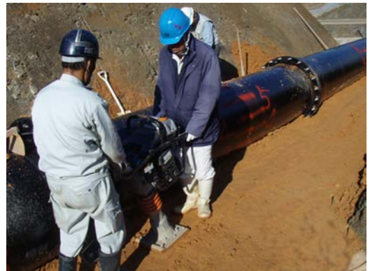
写真4 転圧・埋戻し
