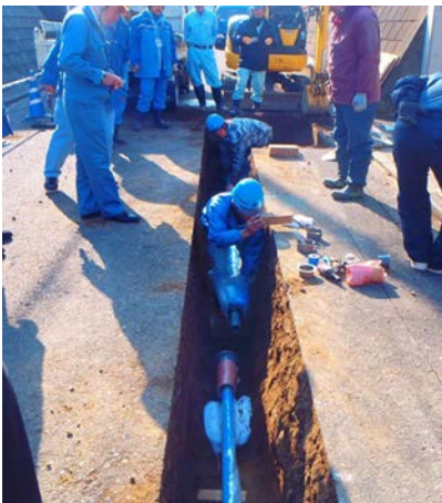
写真1 試験施工現場
