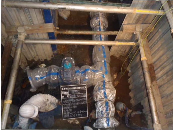
写真3 既設管接続
