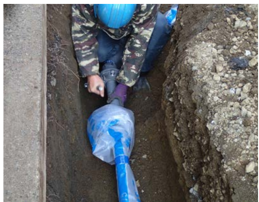
写真5 抜け止め押輪施工 (2)
