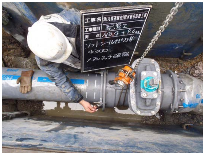
写真4 継手チェック状況
