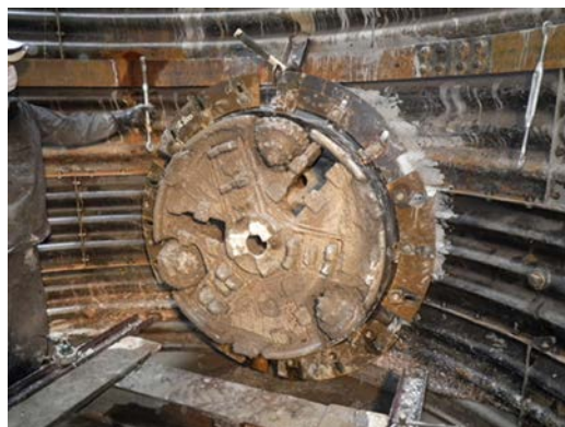
写真5 立坑に到達した掘進機
