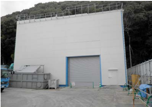
写真6 発進立坑の状況
