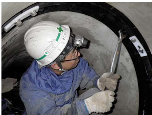
写真4 継手接合状況
