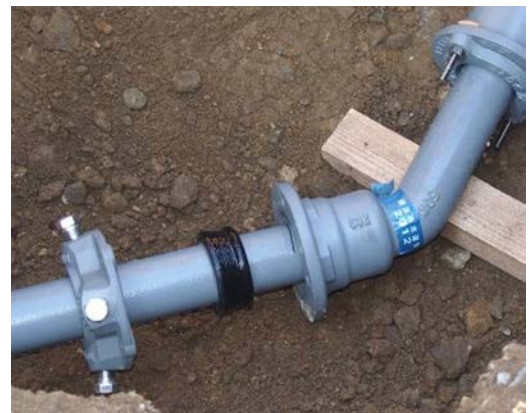
写真4 抜け止め押輪施工 (1)
