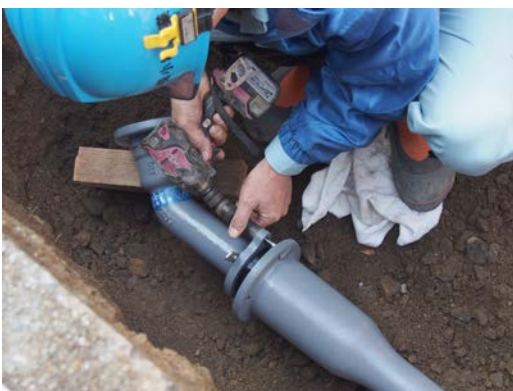
写真2 普通押輪施工 (1)
