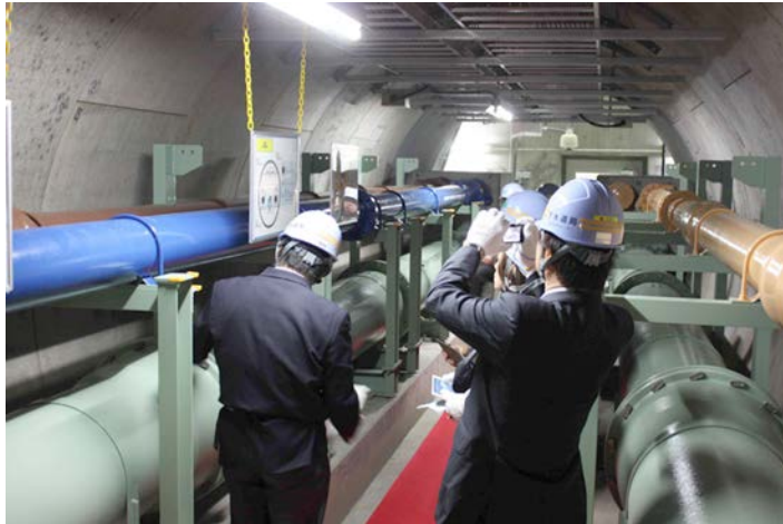
写真5 連絡管内の状況
