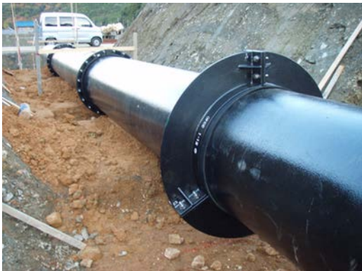
写真2 止水壁の設置
