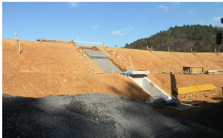
写真5 調査観測時の盛土状況（池の内側）
