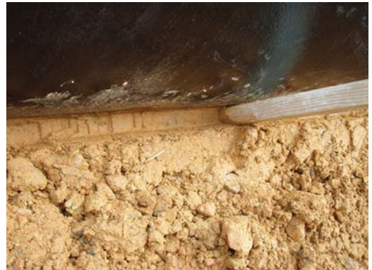
写真3 管底部の突固め
