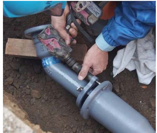
写真3 普通押輪施工 (2)
