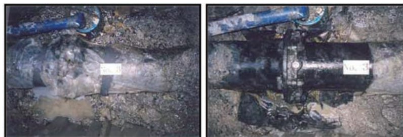
写真No1 埋設20年後の管外面の状況
