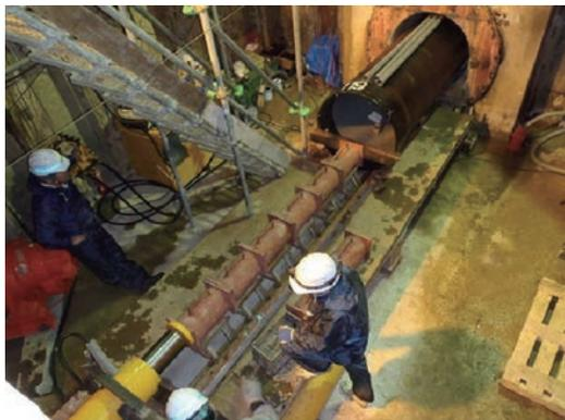
写真11 PN形管挿入状況②
