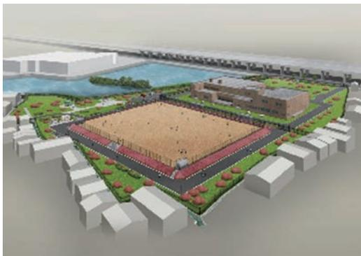
敷地面積は27,324m<sup>2</sup>、浄水池は地下に鉄筋コンクリート造4池(有効容量V=25,000m<sup>3</sup>)、ポンプ棟は地下2階地上2階の鉄筋コンクリート造で、ポンプ室は騒音や振動を考慮して地下2階部に設けられる。ポンプは合計6台(うち1台は予備)設置し、計画送水量371,000m<sup>3</sup>/日(常時)のポンプ場となる予定である。
