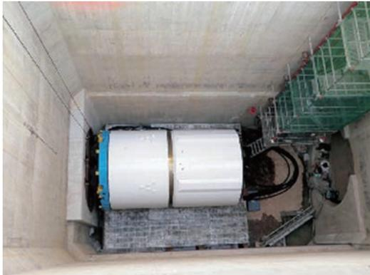
写真2 立杭およびシールドマシン
