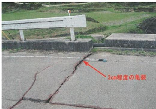
写真1 ため池堤防道路面の亀裂
