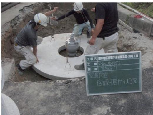
写真3 下水道用空気弁設置状況
