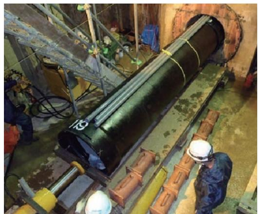
写真10 PN形 管挿入状況①
