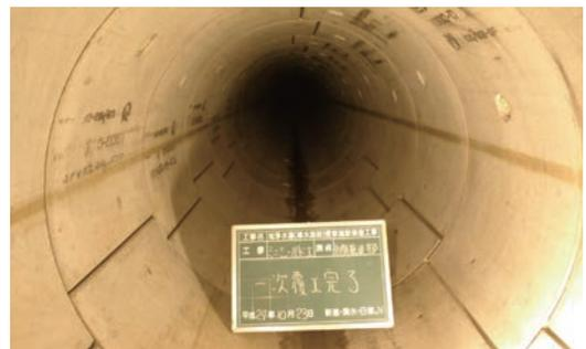
写真4 1次覆工(シールドトンネル)完了
