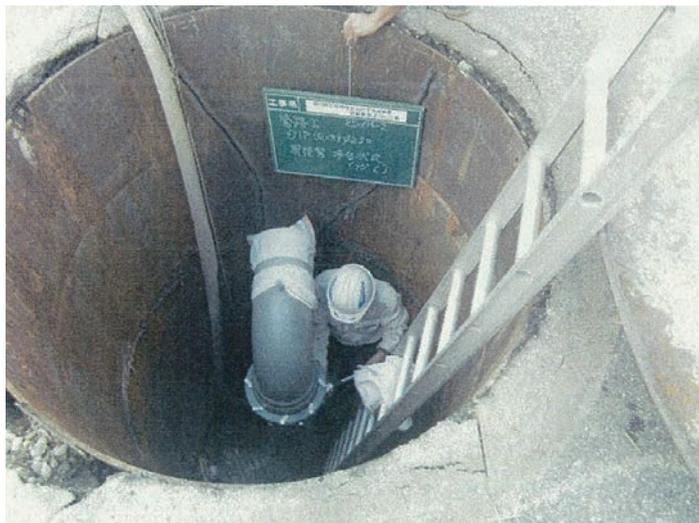
写真2 到達立坑内の配管状況
