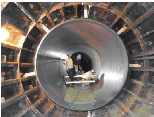
写真4 配管されるダクタイル鉄管
