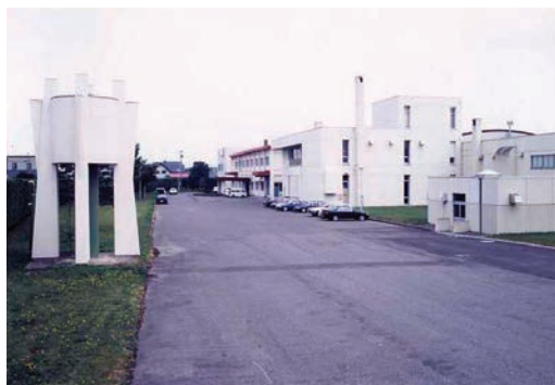
● 石狩川浄水場
