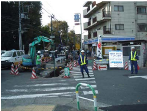
写真1 試験施工の実施環境 (世田谷区給田)
