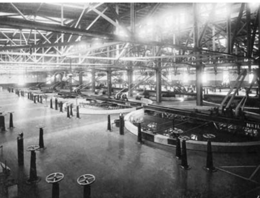
写真3 蹴上浄水場ろ過場の内部(明治45年3月撮影)
