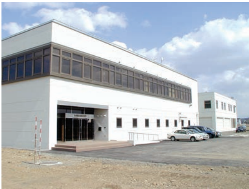
● 忠別川浄水場
