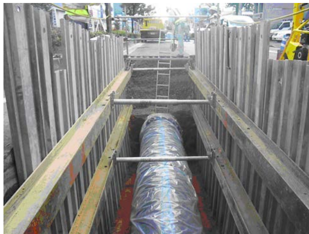
写真6 高機能ダクトイル鉄管布設状況
