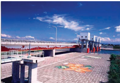
●忠別川浄水場取水堰
