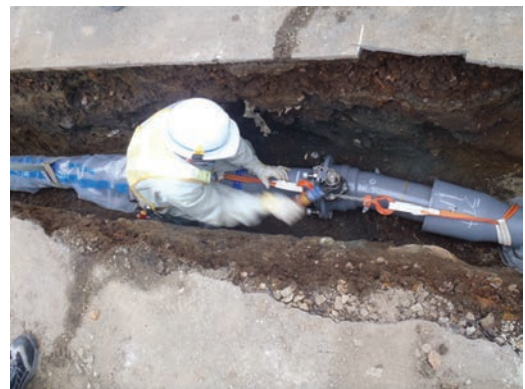
写真6 DIP (GX) φ150 布設状況
