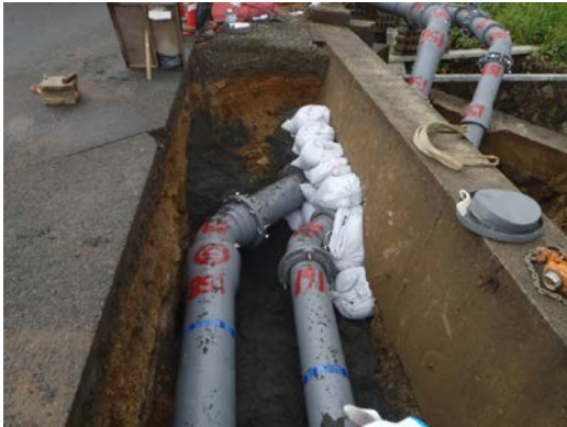
写真3 施工写真(曲管部)
