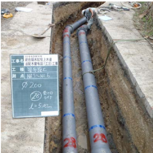
写真5 施工写真(直線部と曲管部)
