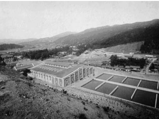
写真2 完成時の蹴上浄水場(明治45年3月撮影)
