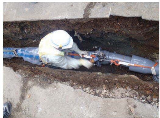
写真6 DIP(GX)φ150 布設状況
