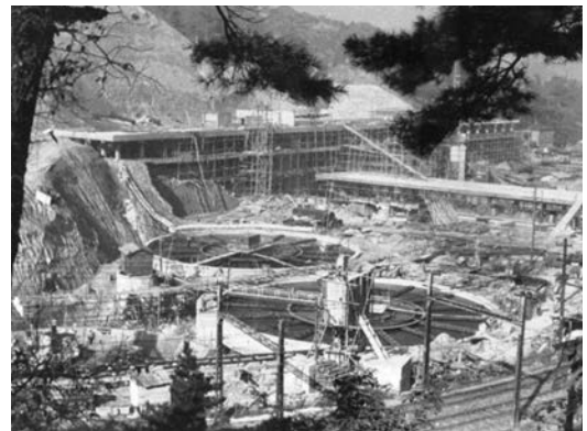
写真4 蹴上浄水場拡張工事(昭和35年11月撮影)
