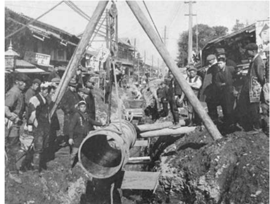
写真5 建仁寺前配水管(24インチ管)の布設工事 (明治44年1月撮影)
