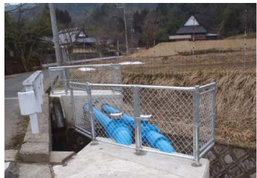
写真6 施工写真(水路横断)
