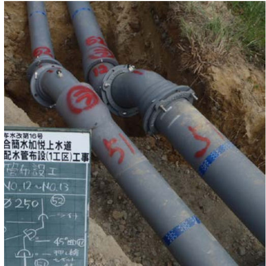
写真4 施工写真(伏越し部)
