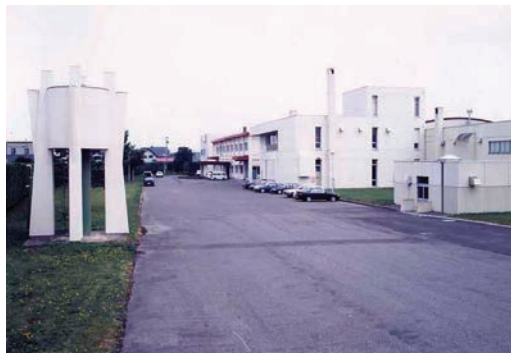
● 石狩川浄水場
