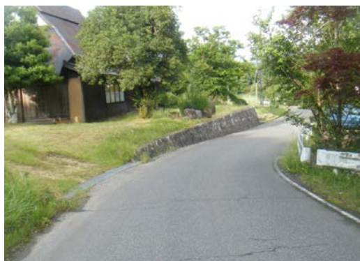
写真2 現地の状況②
