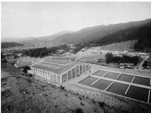
写真2 完成時の蹴上浄水場(明治45年3月撮影)
