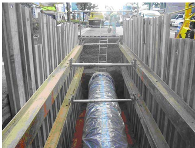
写真6 高機能ダクトイル鉄管布設状況
