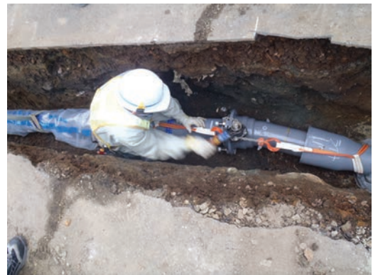
写真6 DIP(GX)φ150 布設状況
