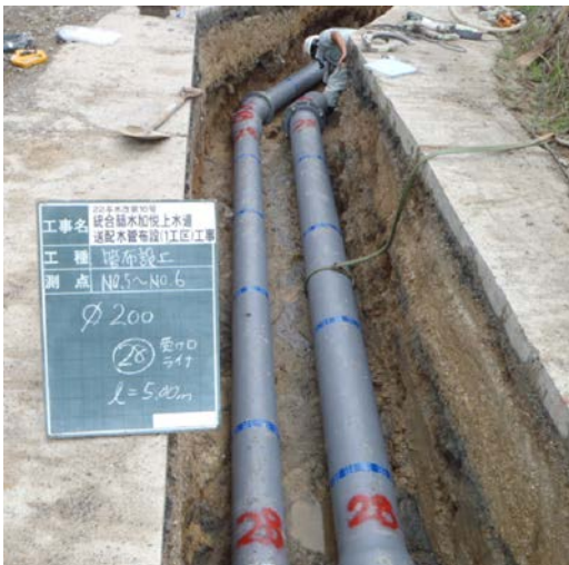
写真5 施工写真(直線部と曲管部)
