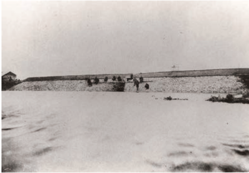
●軍用水道取水口導水閘（東鷹栖1線10号）
