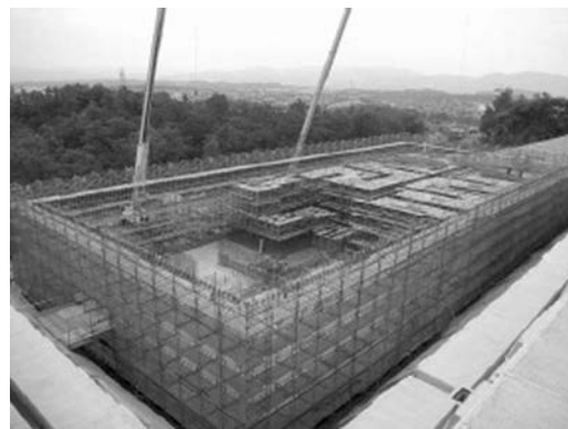
写真8 建設中の調整・配水池
