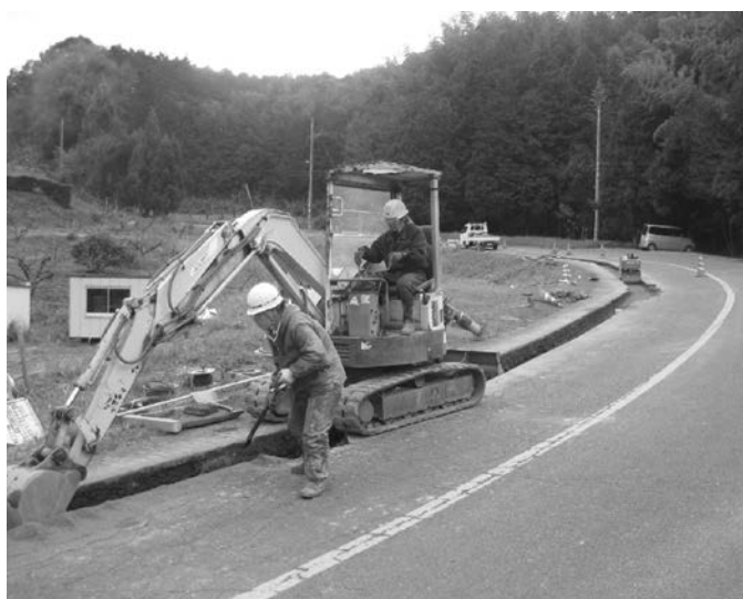
写真1 工事現場状況
