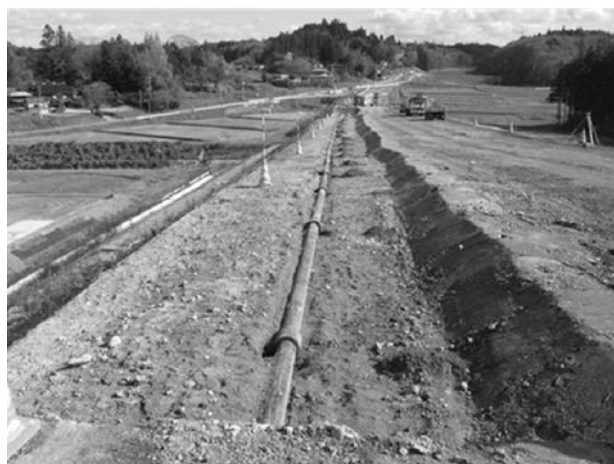
写真9 測点1240m付近から下流側を望む
