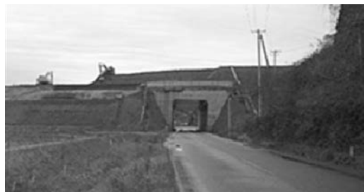
写真2 ボックスカルバート
