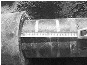
写真12 測点1230m付近 継手測定状況
