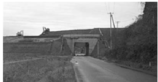
写真2 ボックスカルバート
