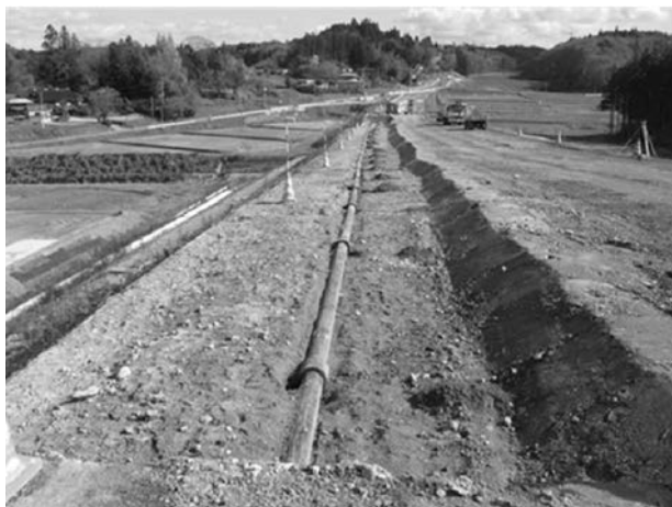
写真9 測点1240m付近から下流側を望む
