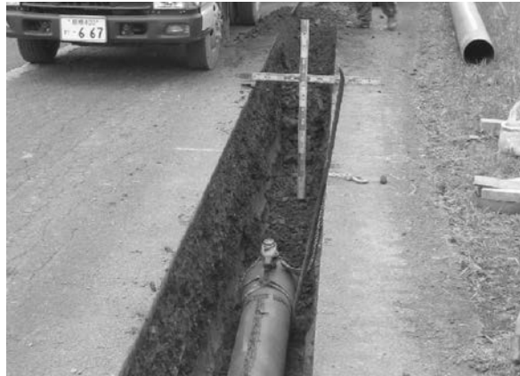
写真2 GX形管呼び径250 掘削=60cm
