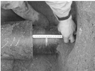
写真11 測点1220m付近 継手測定状況
