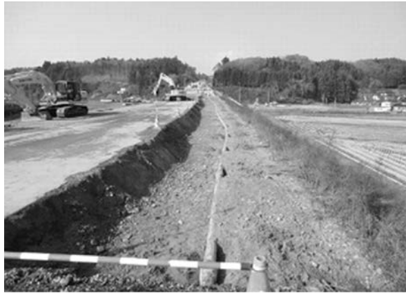
写真10 測点1500m付近から上流側を望む
