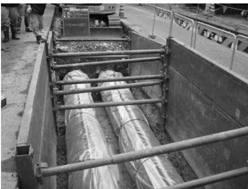
写真3 連絡管布設状況
