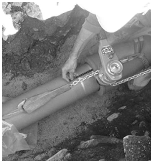
写真4 GX形施工状況②
