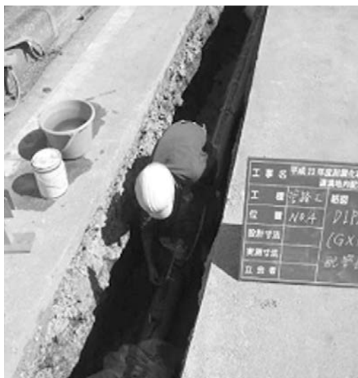
写真3 GX形施工状況①
