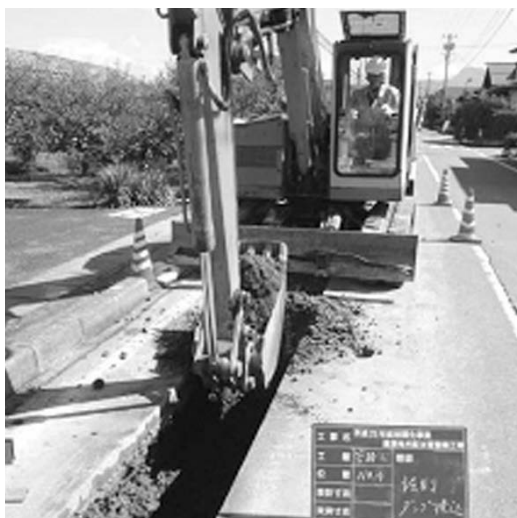
写真1 掘削状況①
