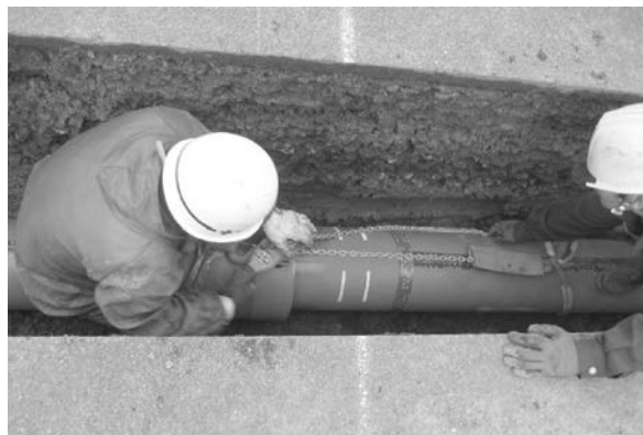
写真3 GX形呼び径250接合状況
