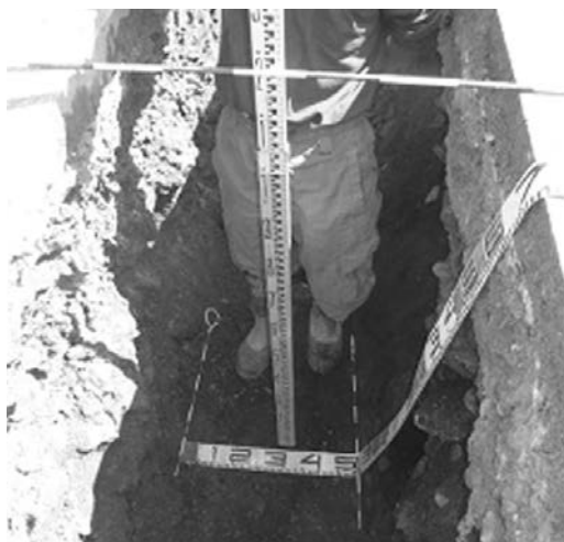
写真2 掘削状況② (幅500mm 深さ1170mm)
