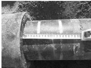
写真12 測点1230m付近 継手測定状況
