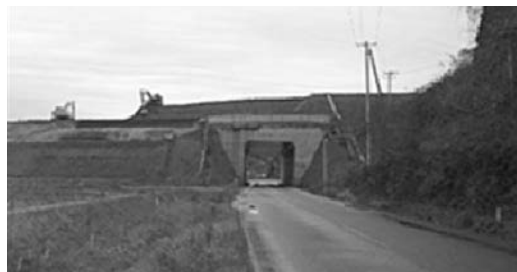
写真2 ボックスカルバート
