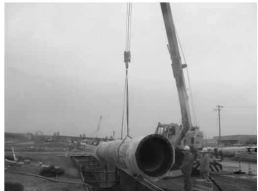
写真1 海側幹線施工中の状況
