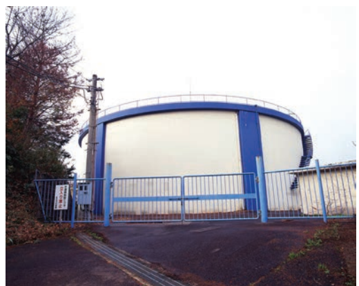
■橋北給水改善事業で完成した春日配水池
