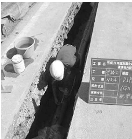
写真3 GX形施工状況①
