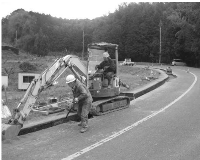
写真1 工事現場状況
