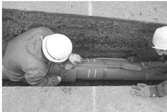
写真3 GX形呼び径250接合状況
