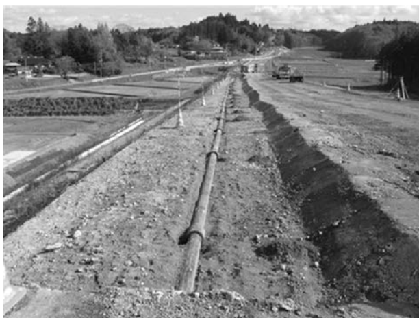
写真9 測点1240m付近から下流側を望む
