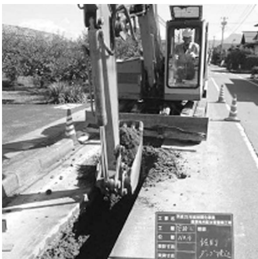
写真1 掘削状況①
