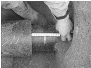
写真11 測点1220m付近 継手測定状況
