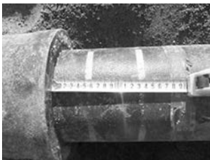
写真12 測点1230m付近 継手測定状況
