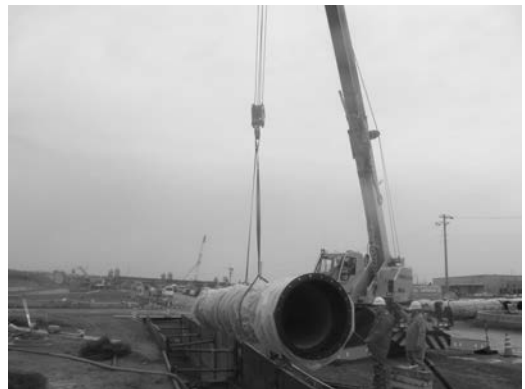
写真1 海側幹線施工中の状況
