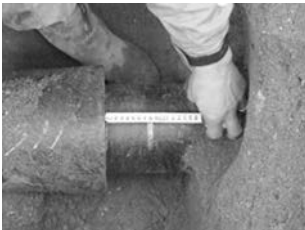
写真11 測点1220m付近 継手測定状況
