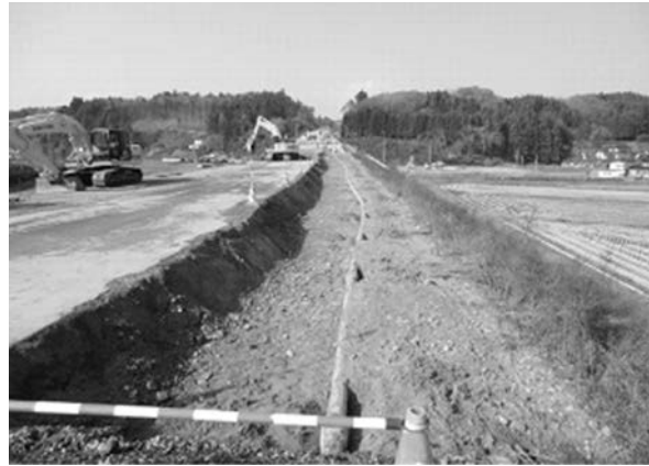
写真10 測点1500m付近から上流側を望む
