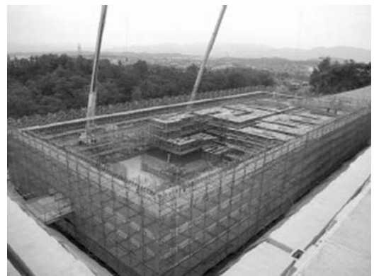
写真8 建設中の調整・配水池
