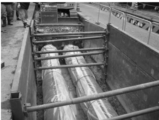
写真3 連絡管布設状況
