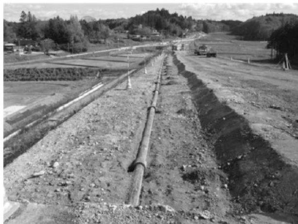
写真9 測点1240m付近から下流側を望む
