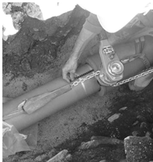
写真4 GX形施工状況②
