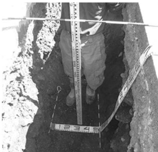
写真2 掘削状況② (幅500mm 深さ1170mm)
