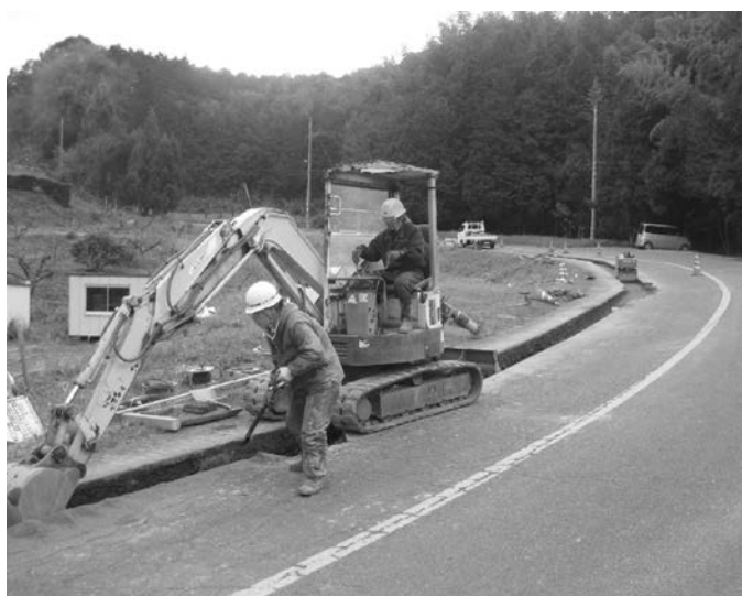
写真1 工事現場状況
