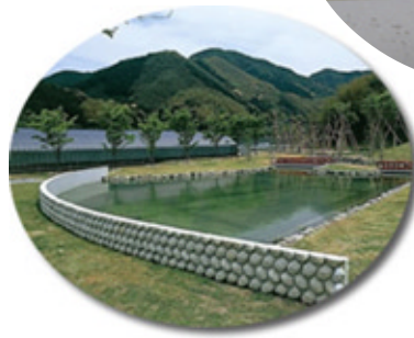
●やまめの池(井手浦浄水場)
