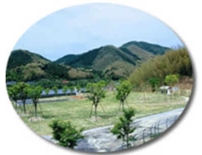
●やまめの里全景(井手浦浄水場)
