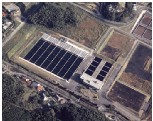
●井手浦浄水場
