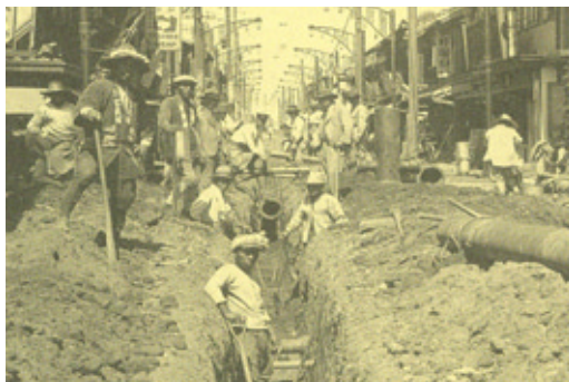
●旧戸畑市（配水管布設工事）
