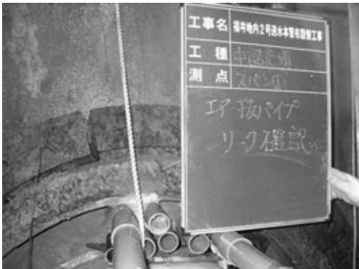
写真5 中詰りの施工状況(流動化充填材)
