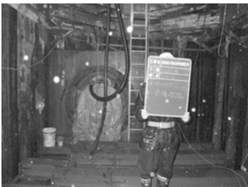
写真6 中詰りの施工状況(流動化充填材)
