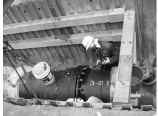
写真3 ダクタイル鉄管S形呼び径900布設状況
