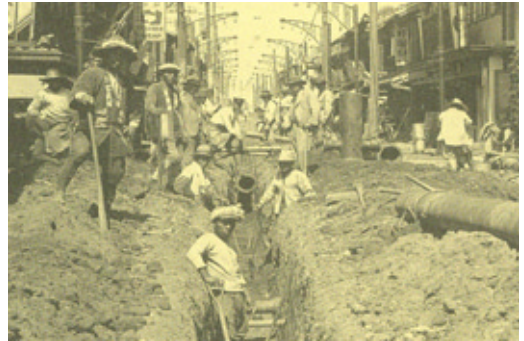
●旧戸畑市（配水管布設工事）
