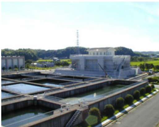
●高度浄水処理施設(本城浄水場)
