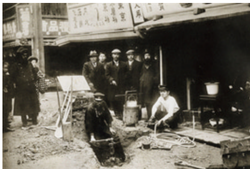
●旧門司市（水道創設時の給水管布設）
