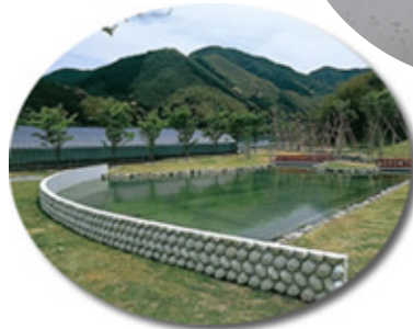
●やまめの池(井手浦浄水場)
