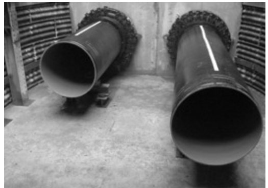
写真5 発進立坑(推進完了後)
