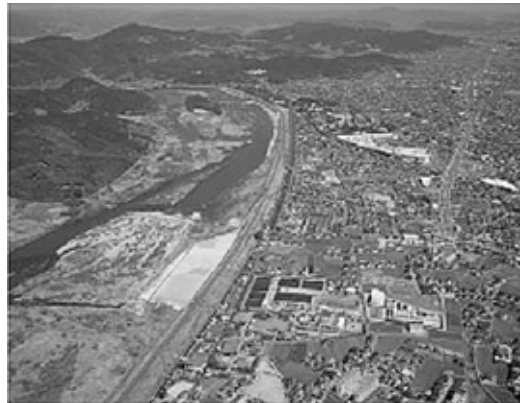
写真1 西阿知浄水場周辺
