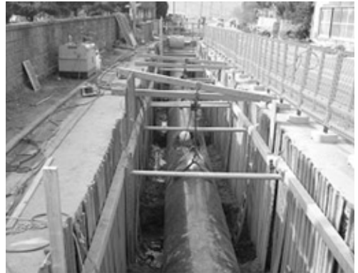
写真5 鋼管呼び径1000の布設状況
