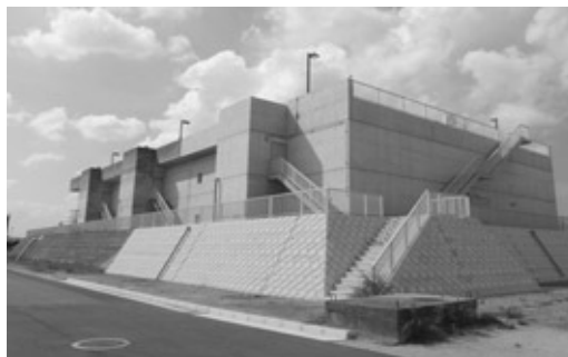
写真2 高度浄水処理施設
