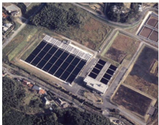
●井手浦浄水場
