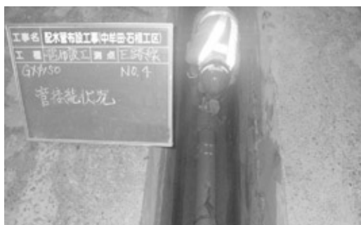
写真2 直管部の接合状況
