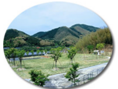
●やまめの里全景(井手浦浄水場)
