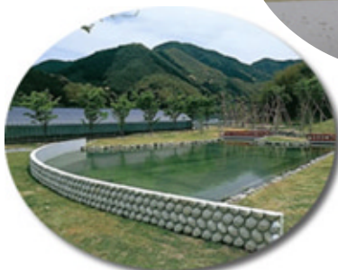
●やまめの池(井手浦浄水場)
