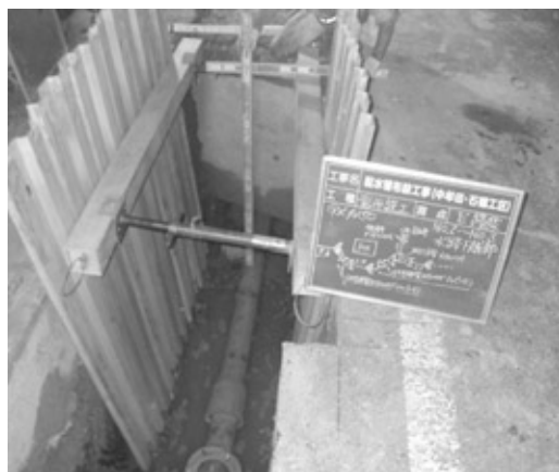
写真4 伏せ越し部接合状況
