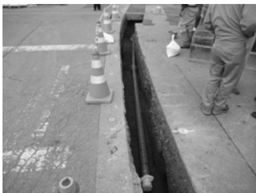
写真4 GX形布設状況
