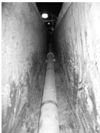
写真1 直管部の布設状況
