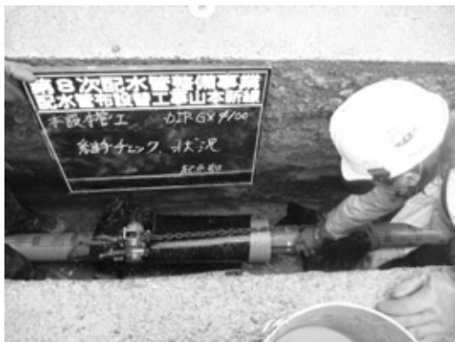
写真3 GX形直管接合状況
