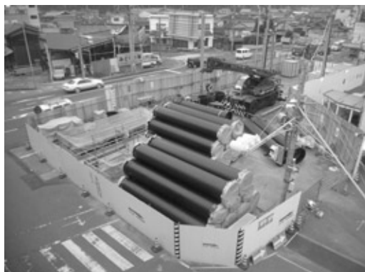
写真3 NS形ダクタイル鉄管の仮置状況
