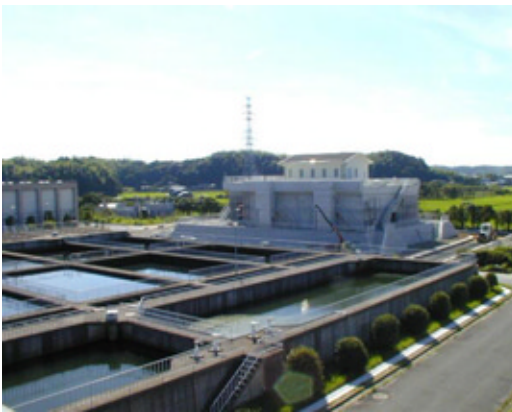
●高度浄水処理施設(本城浄水場)
