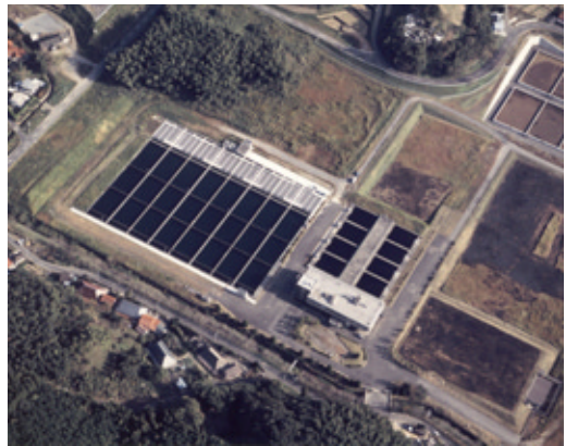
●井手浦浄水場
