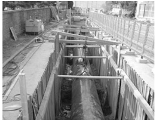
写真5 鋼管呼び径1000の布設状況
