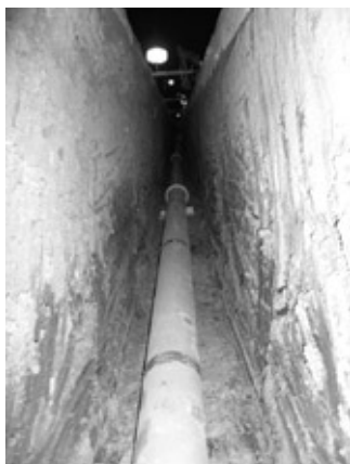
写真1 直管部の布設状況
