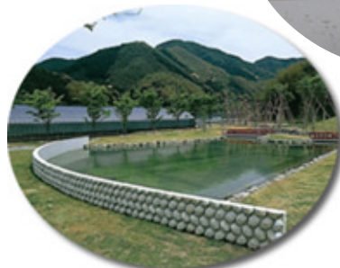
●やまめの池(井手浦浄水場)
