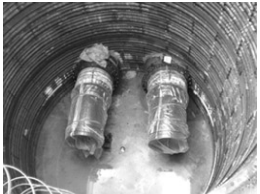
写真6 到達立坑(推進完了後)
