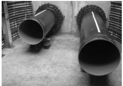
写真5 発進立坑(推進完了後)
