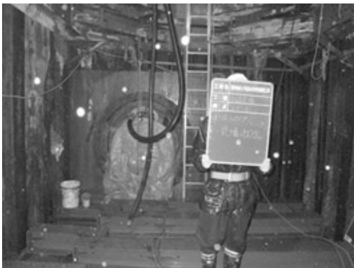
写真6 中詰りの施工状況(流動化充填材)
