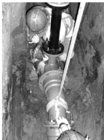
写真3 異形管接合状況
