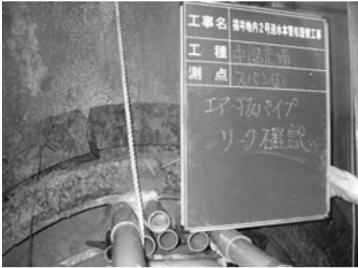
写真5 中詰りの施工状況(流動化充填材)
