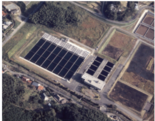
●井手浦浄水場
