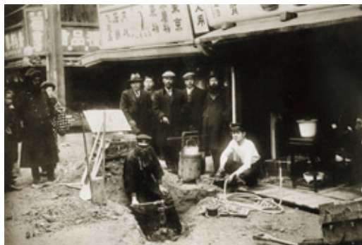
●旧門司市（水道創設時の給水管布設）
