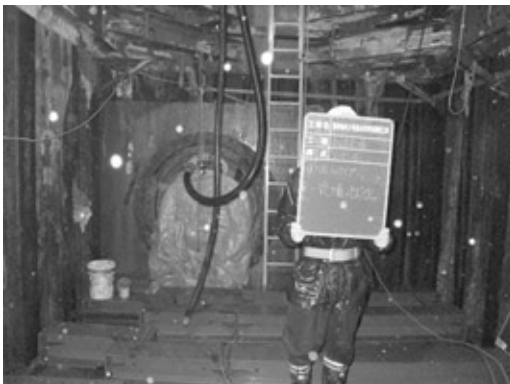
写真6 中詰りの施工状況(流動化充填材)
