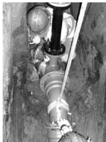
写真3 異形管接合状況
