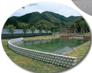
●やまめの池(井手浦浄水場)
