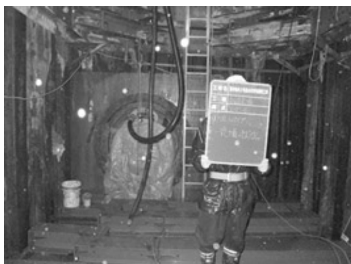
写真6 中詰工の施工状況(流動化充填材)
