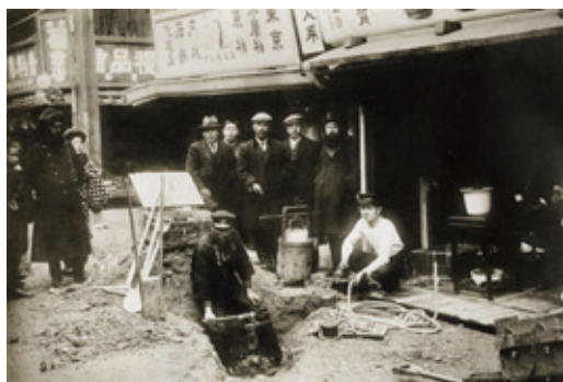
●旧門司市（水道創設時の給水管布設）
