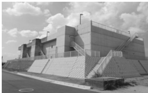
写真2 高度浄水処理施設
