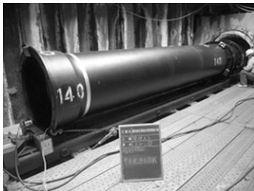
写真4 NS形ダクトイル鉄管の推進状況(スパン1側)
