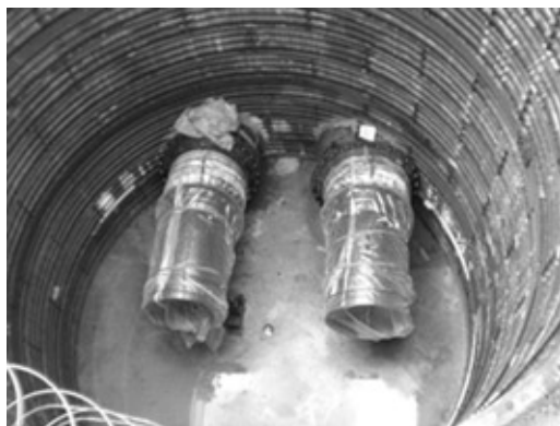
写真6 到達立坑(推進完了後)
