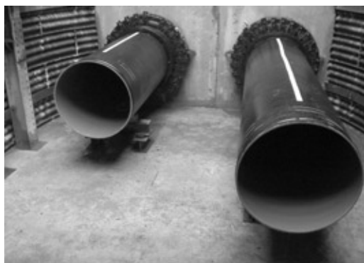
写真5 発進立坑(推進完了後)
