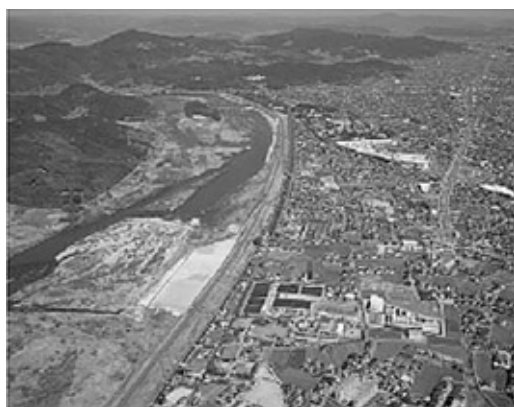
写真1 西阿知浄水場周辺
