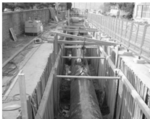
写真5 鋼管呼び径1000の布設状況
