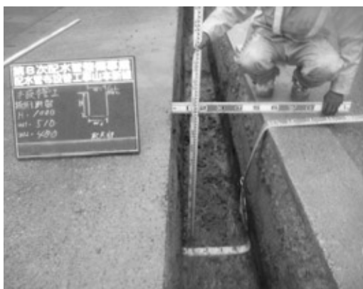
写真2 掘削断面
