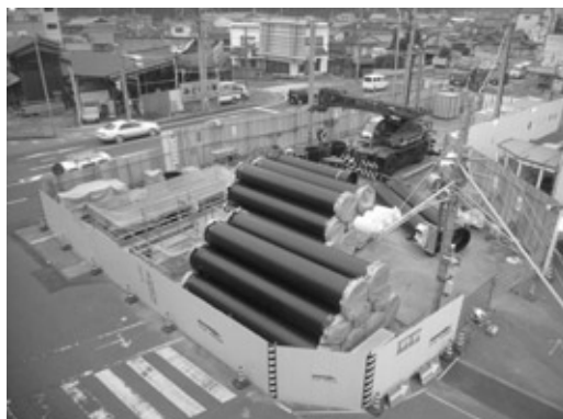
写真3 NS形ダクトイル鉄管の仮置状況
