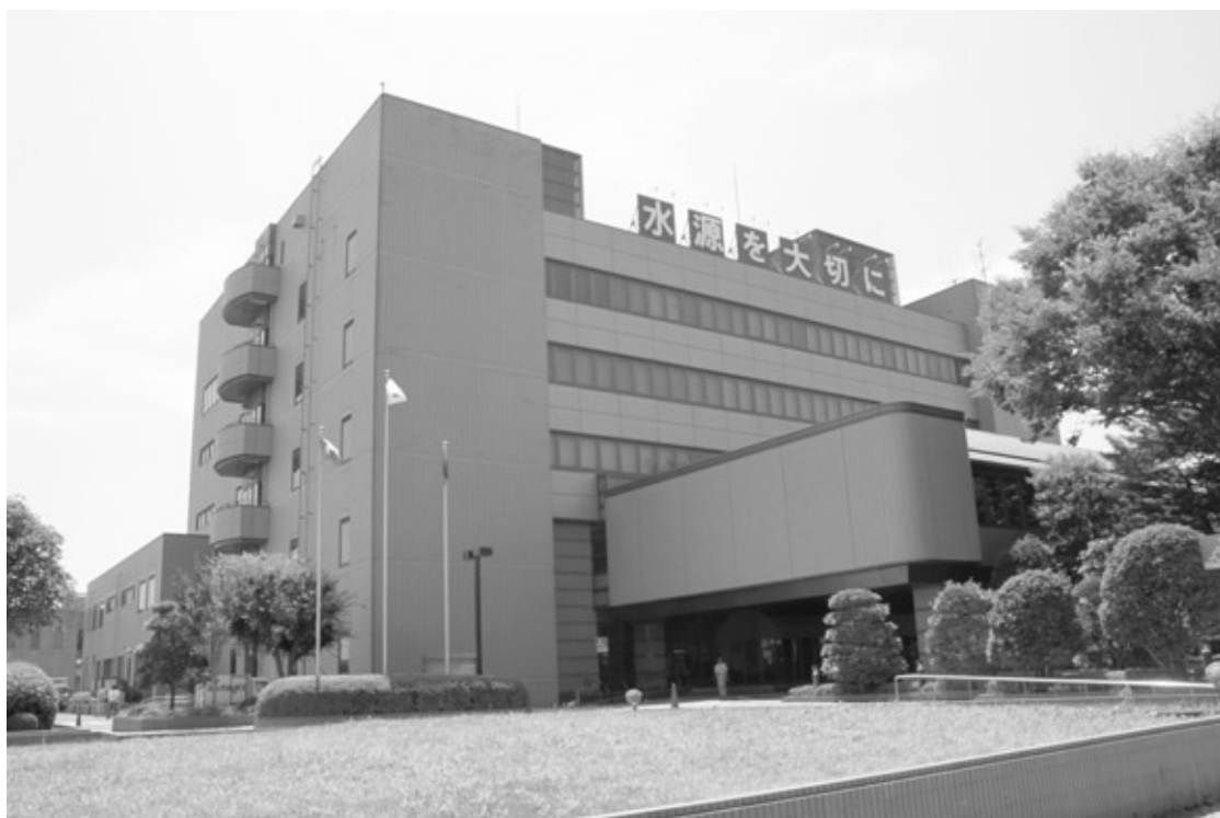
●仙台市水道局庁舎
