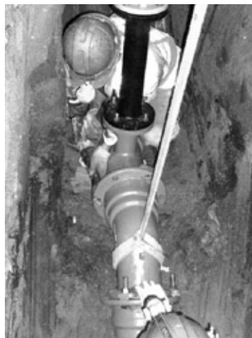
写真3 異形管接合状況
