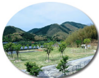
●やまめの里全景（井手浦浄水場）
