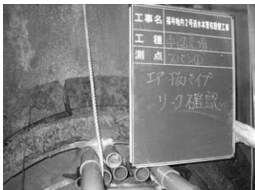
写真5 中詰工の施工状況(流動化充填材)
