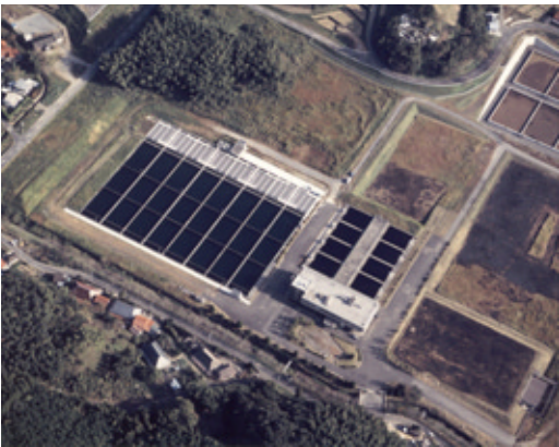
●井手浦浄水場
