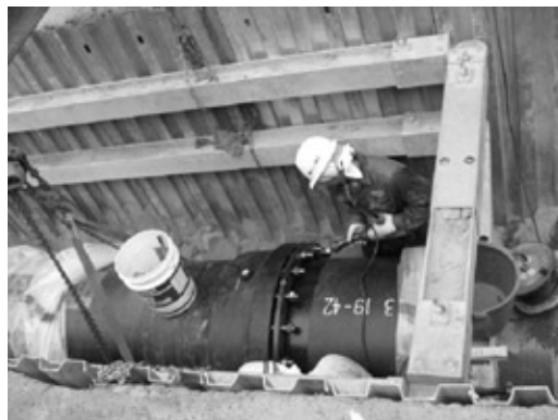
写真3 ダクタイトイル鉄管S形呼び径900布設状況
