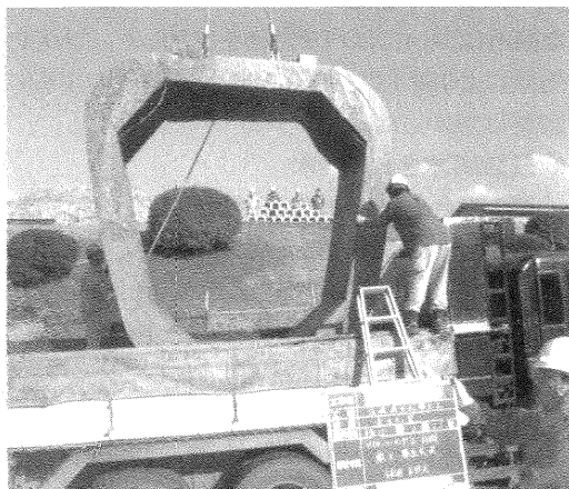
写真7 導水きよ輪切り
