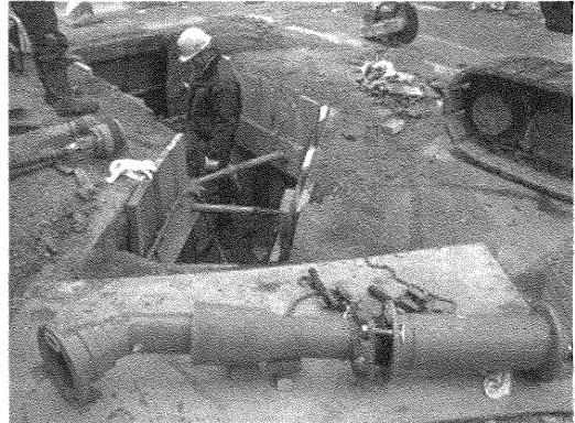
写真3 切り回し配管の陸組み状況
