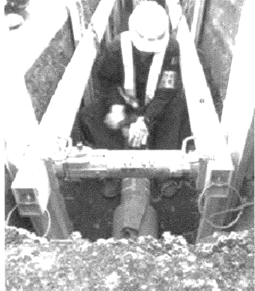
写真2 直管接合状況 (接合作業幅60cm)
