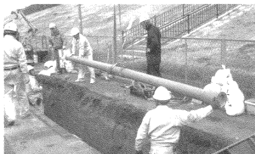
写真1 呼び径150GX形の吊り込み状況
