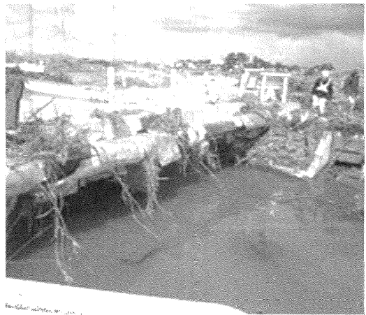
写真11 呼び径350NS形管橋梁添架 (津波による洗掘箇所:被害なし)
