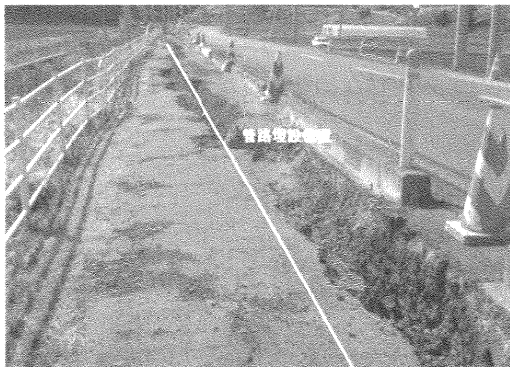
写真12 呼び径900S形管埋設箇所 (地盤沈下箇所:被害なし)
