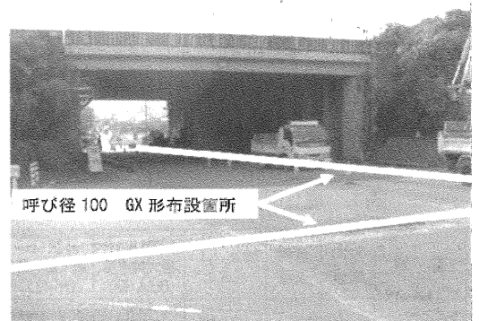
写真1 工事現場状況
