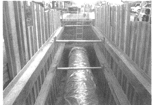
●水道耐震管の布設
