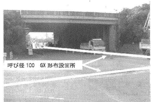
写真1 工事現場状況
