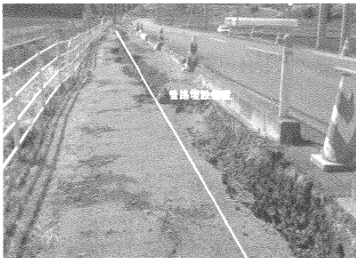
写真12 呼び径900S形管埋設箇所 (地盤沈下箇所:被害なし)
