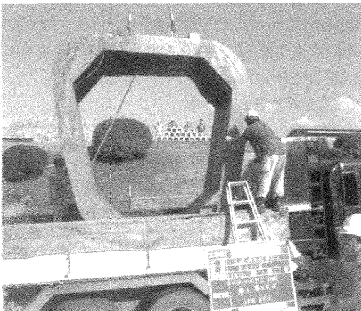
写真7 導水きよ輪切り
