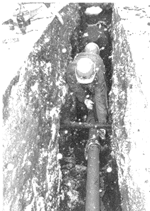
写真2 直管の接合作業
