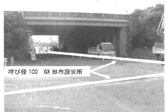
写真1 工事現場状況
