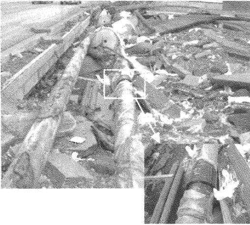
写真10 呼び径300NS形管 (津波による洗掘箇所:被害なし)
