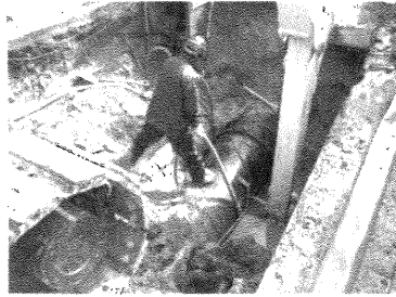
いわき市での幹線管路応急復旧作業(25日)
