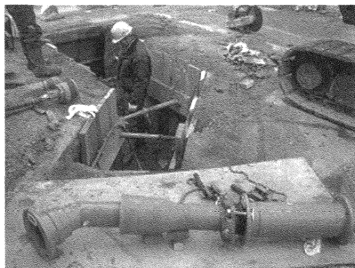
写真3 切り回し配管の陸組み状況
