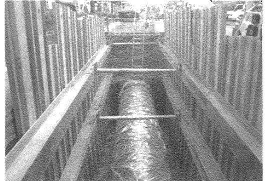
●水道耐震管の布設
