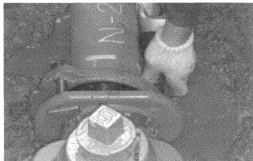
写真5 GX形異形管接合
