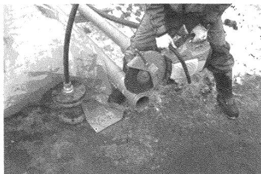
写真1 挿し口の切断作業
