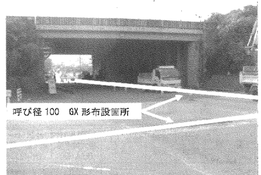
写真1 工事現場状況
