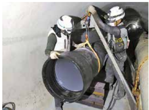
写真 11 布設場所での管の吊り下し状況
