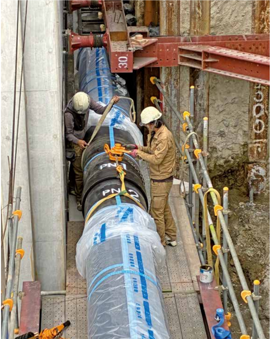
岡山市水道局 PN形 呼び径700
