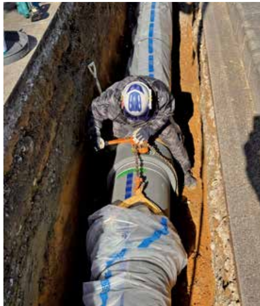
志摩市上下水道部（三重県） GX 形 呼び径 450
