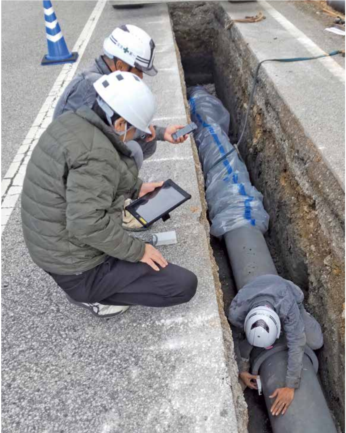
長浜水道企業団（滋賀県） GX 形 呼び径 350
