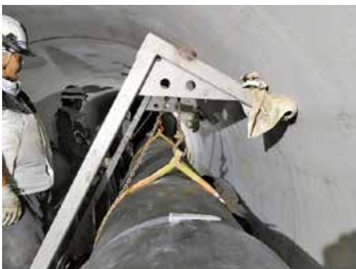
写真 10 布設場所での管吊り上げ状況
