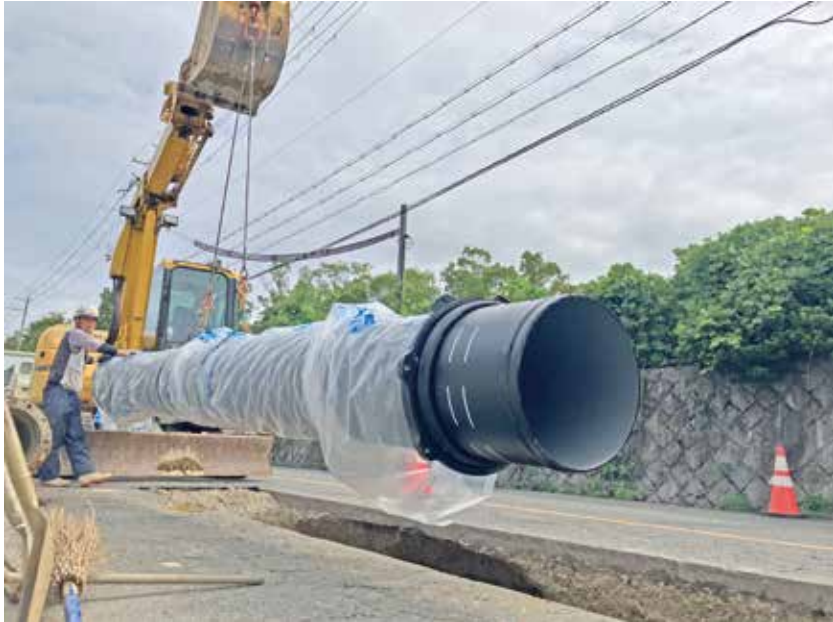
河内長野市上下水道部（大阪府） GX 形 呼び径 500
