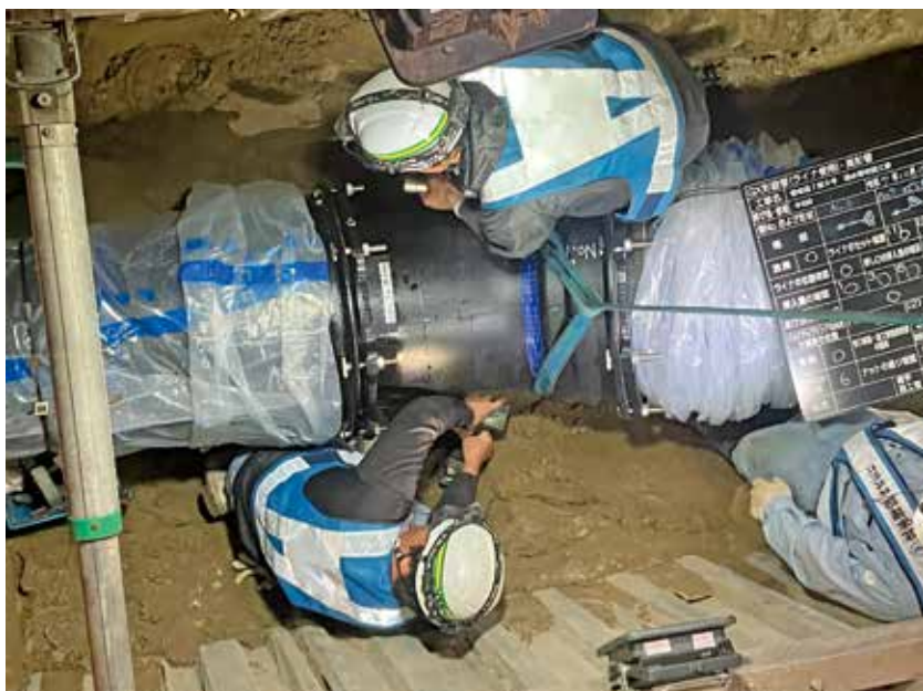
新潟市水道局 GX形 呼び径 500
