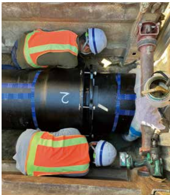
長野市上下水道局 GX形 呼び径 600
