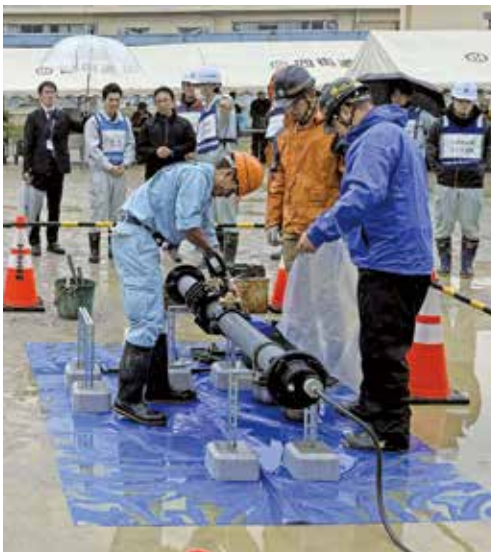
漏水管修理デモの様子と四街道市長
