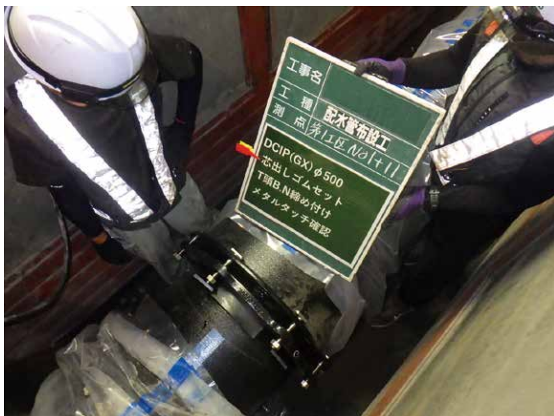
富士市上下水道部（静岡県） GX 形 呼び径 500
