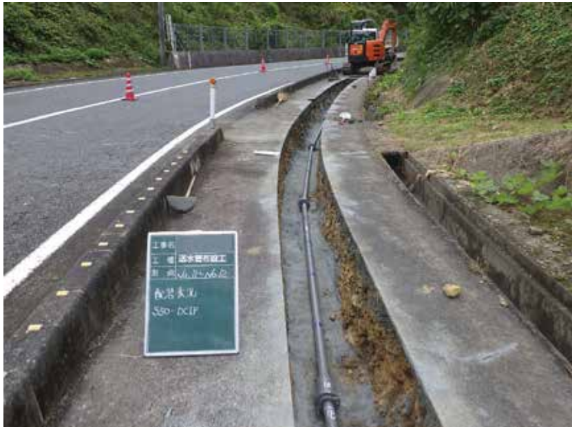
真庭市建設部上下水道課（岡山県） S 50 形 呼び径 50
