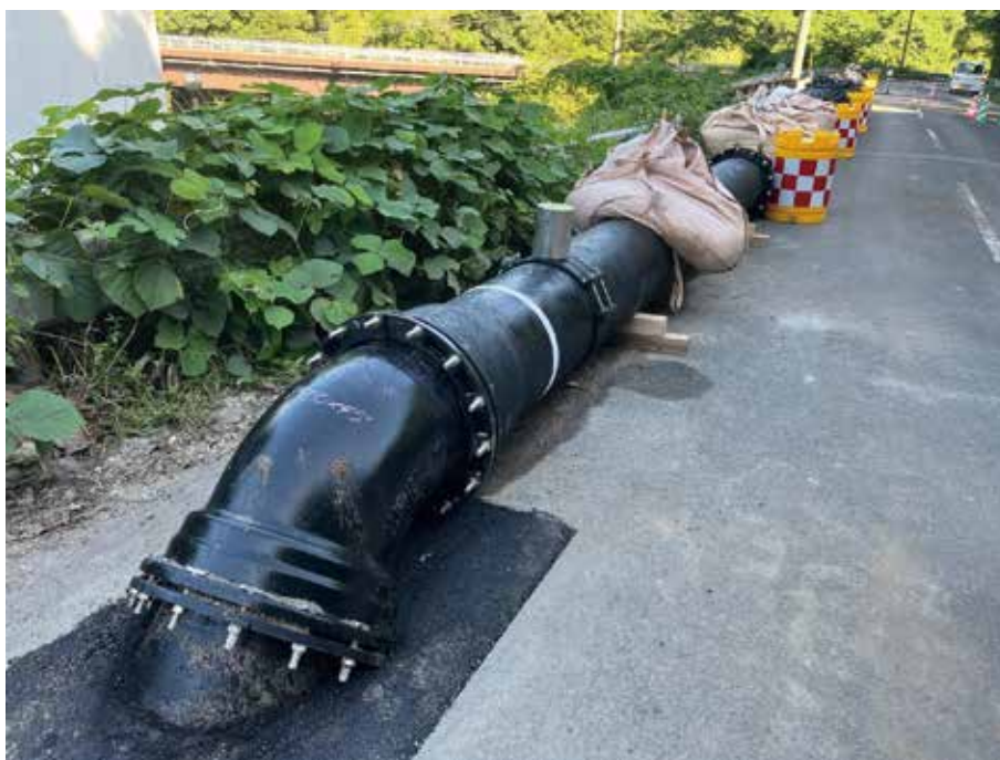
霧島市上下水道部（鹿児島県） NS形 呼び径500
