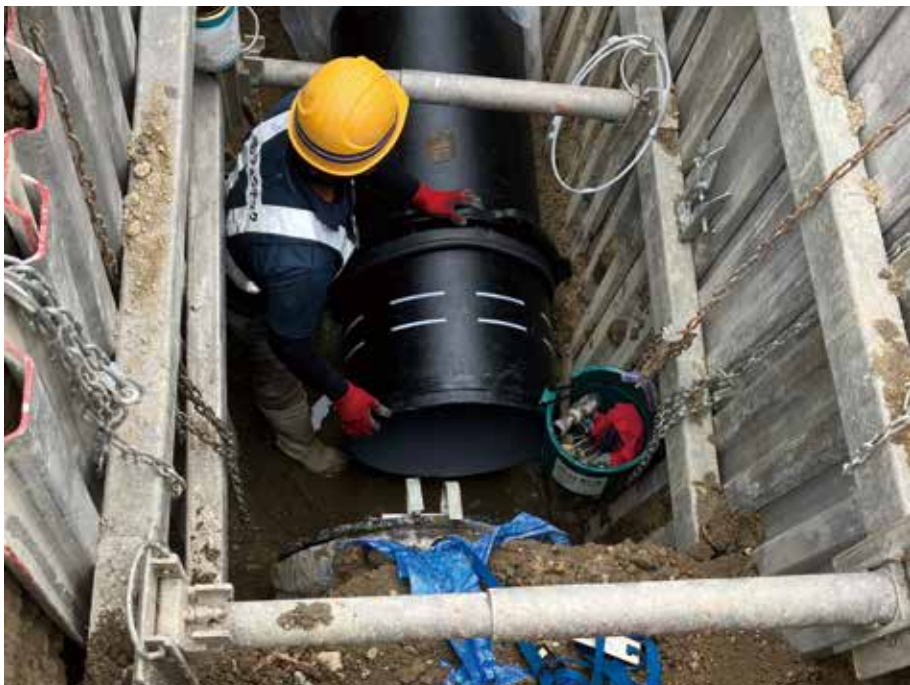
名古屋市上下水道局 GX 形 呼び径 600
