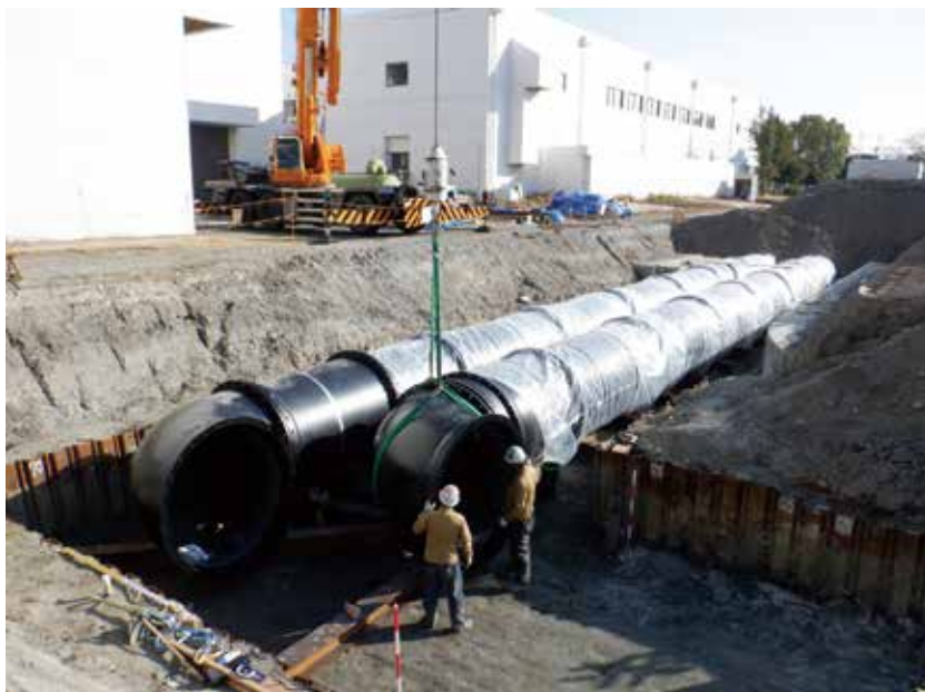
横浜市下水道河川局 K形 呼び径 1650
