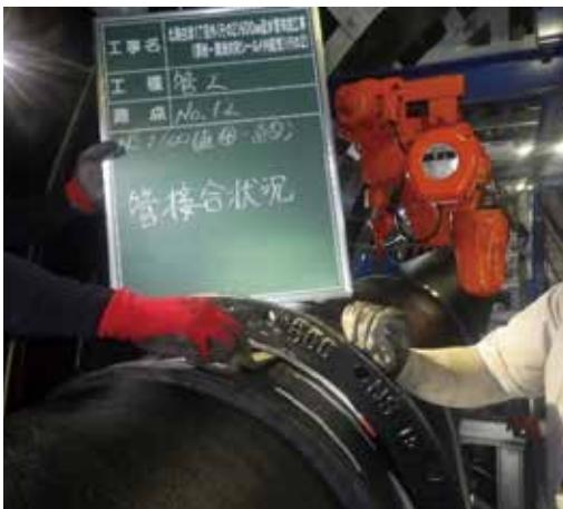
写真 20 φ600 NS 継手工(偏位測定)
