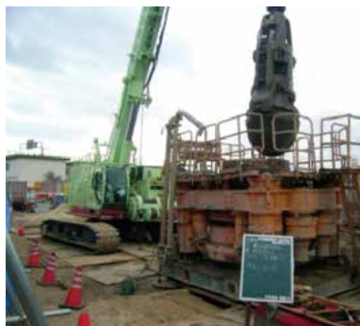
写真6 オールケーシング施工状況
