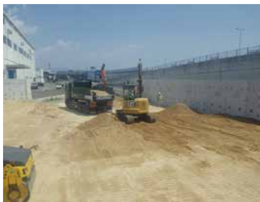
写真 7 発進立坑用地盛土状況
