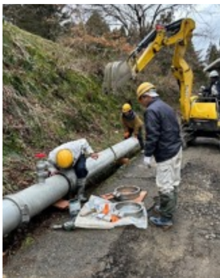
送水管の仮設配管【2月】
