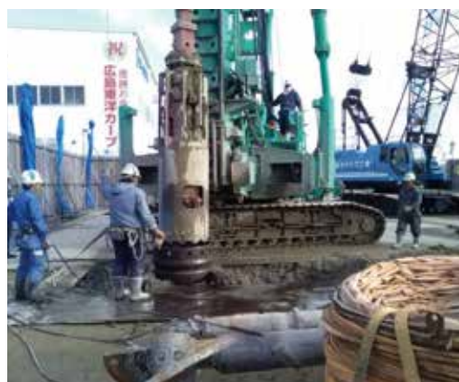
写真5 ロックオーガー施工状況
