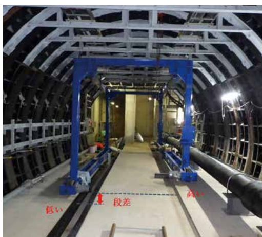
写真 11 門型クレーン設置(インバート段差解消)
