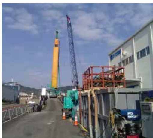
写真4 SMW 施工状況
