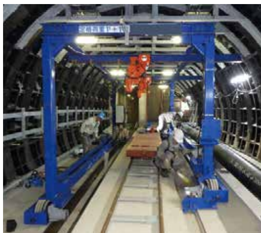
写真 12 シールド内 門型クレーン組立
