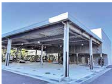
水道技術研修施設
