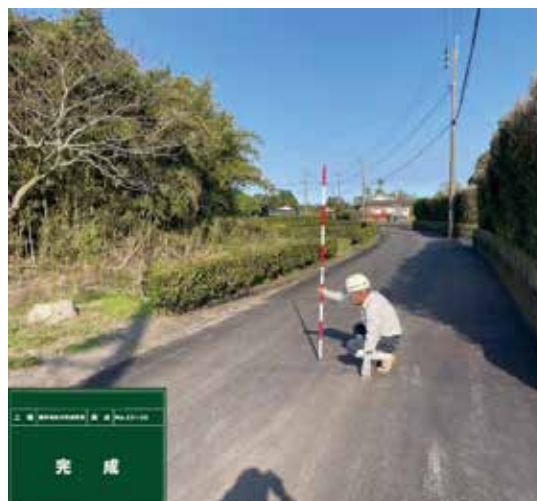
写真6 工事完了(道路復旧後)
