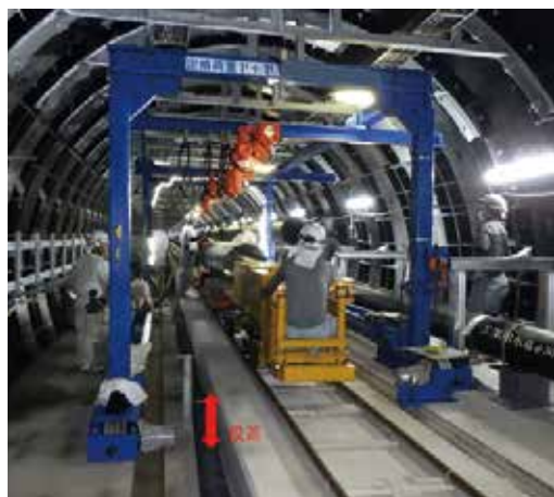
写真 15 シールド内 管据付②
