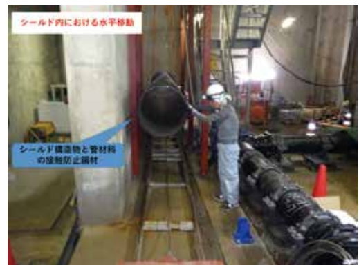
写真9 φ600 構内運搬
