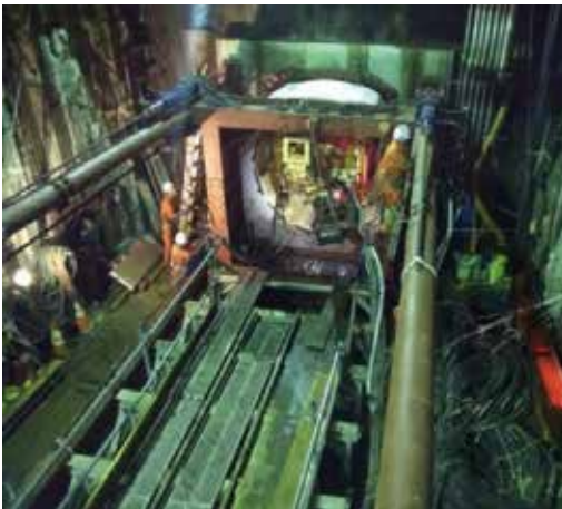
写真9 移動式バックアンカー施工状況
