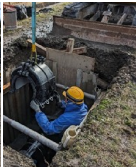
送水管の修繕【2月】
