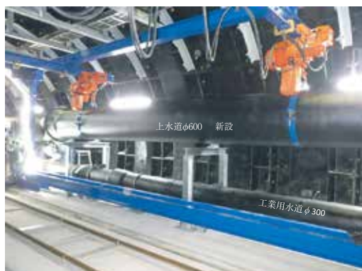
写真 16 シールド内 管据付③
