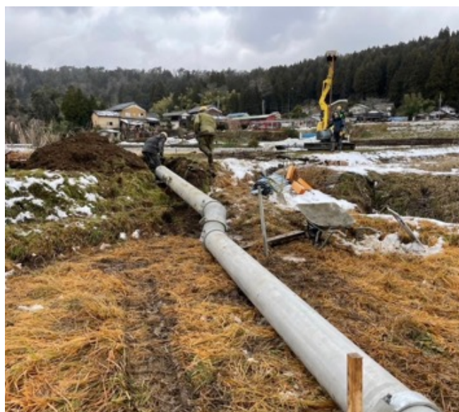
宝立浄水場導水管の仮設配管【1月】
