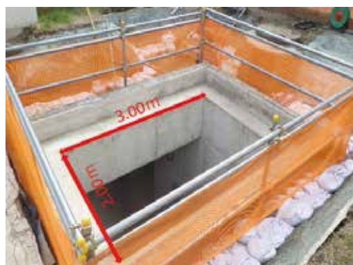
写真5 立坑開口部(材料搬入口)
