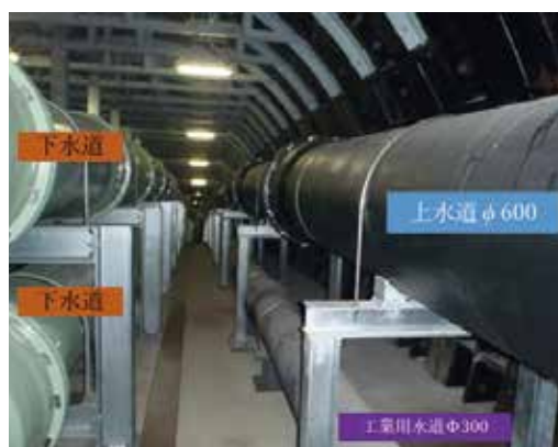
写真4 令和6年度 シールド内巡視・点検 (管据付2年後、塗装状態は健全)
