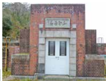
旧佐波浄水場配水池（現在）
