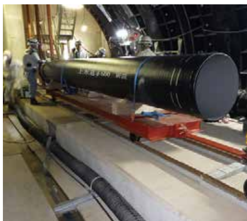
写真 13 シールド内 管運搬
