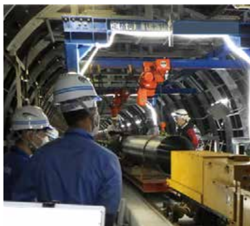
写真 14 シールド内 管据付①
