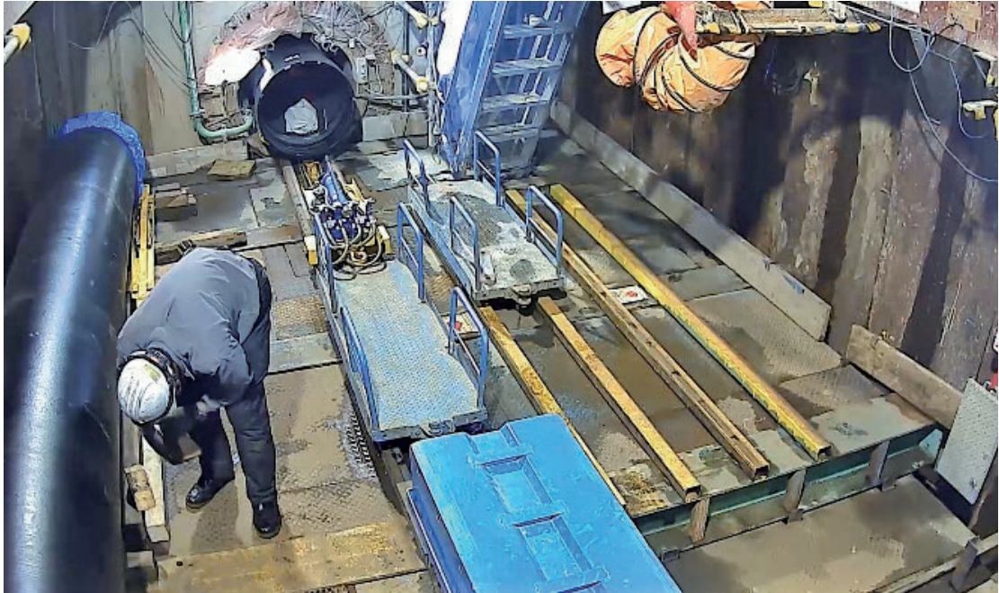
写真4 PN形ダクトイル鉄管運搬状況(立坑内)
