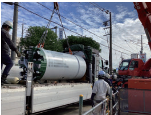
写真 2 シールドマシン搬入状況
