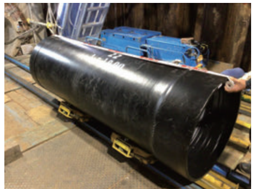
写真 3 PN 形ダクタイトイル鉄管
