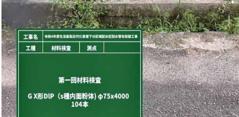
写真2 材料検査状況
