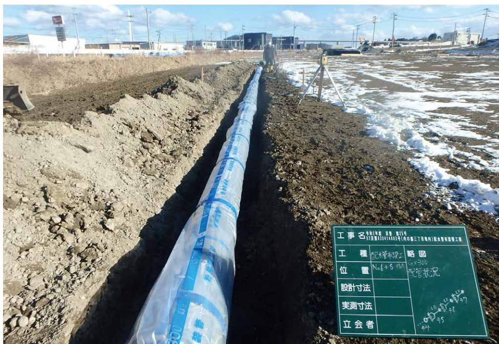
内の脇地内復旧復興工事（気仙沼市）
