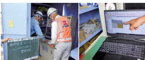
写真5 オペレーターとの土中地形確認
