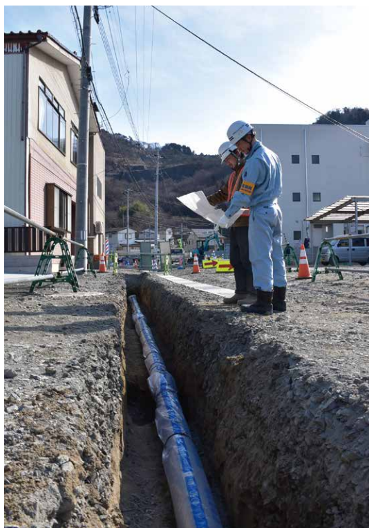
配水管布設（稲井地区）（石巻地方広域水道企業団）
