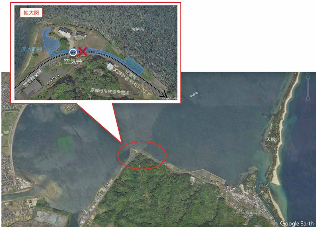
図3 漏水発生箇所
