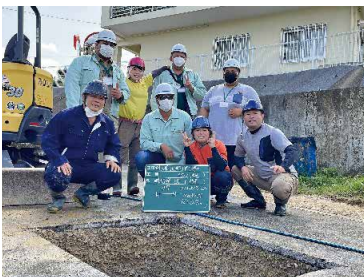
漏水修理を終えて記念撮影
