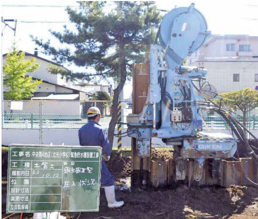
写真1 鋼矢板圧入状況
