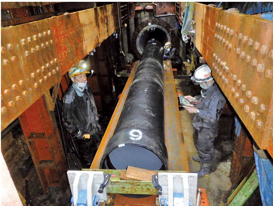
東京都水道局 US形 呼び径 1000 / PN形 呼び径 600
