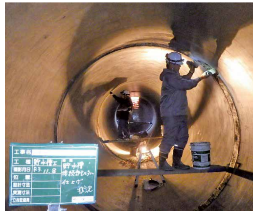
写真7 直管接合部モルタル仕上げ状況
