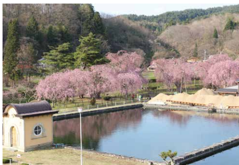
緩速ろ過池とヤエベニシダレヒガンザクラ
