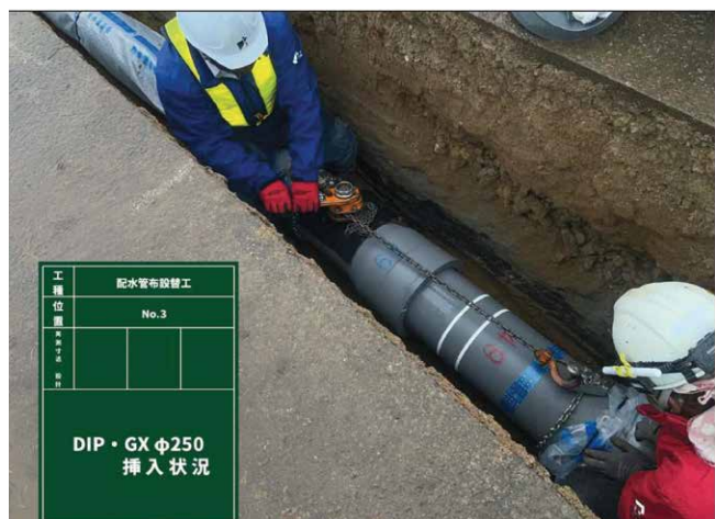
施工現場（会津若松市）
