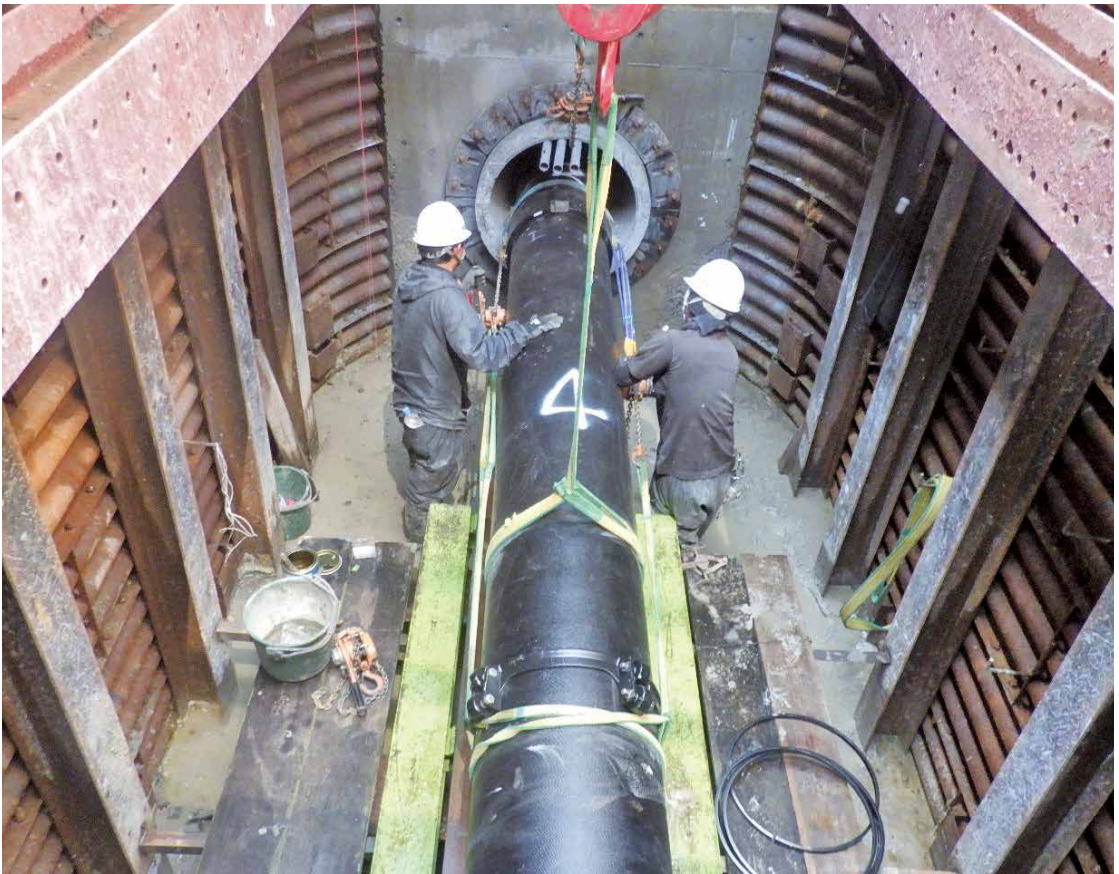
倉敷市水道局(岡山県) PN形 呼び径 500
