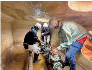
減圧弁の点検作業を実践する研修員
