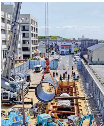
緊急用貯水槽吊込み状況
