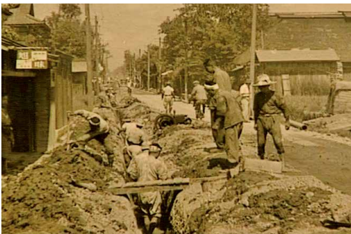
写真3 人力による掘削状況
