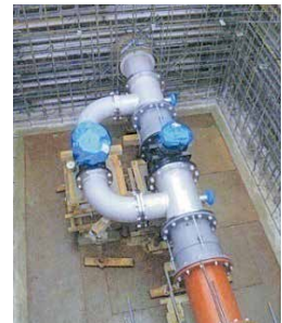
写真8 香澄町配水制御所の整備(コントロールバルブ主弁φ400、副弁φ250)
