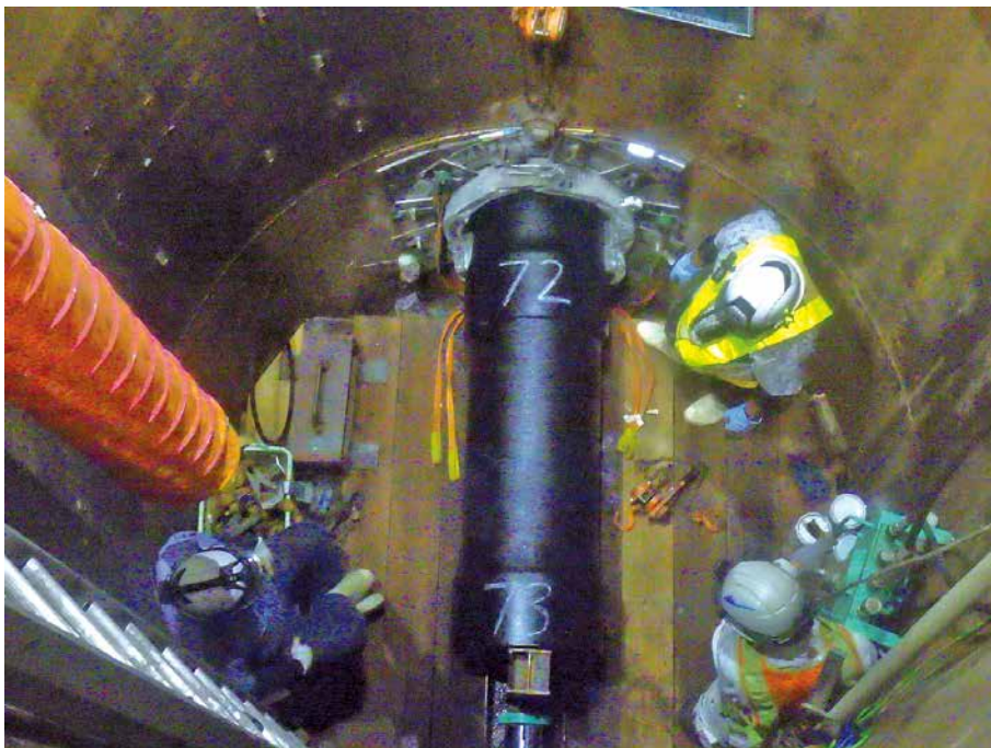
宇治市上下水道部(京都府) GX形 呼び径 450 / PN形 呼び径 500
