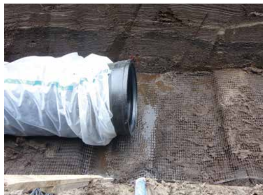
写真1 不同沈下抑制シート敷設状況
