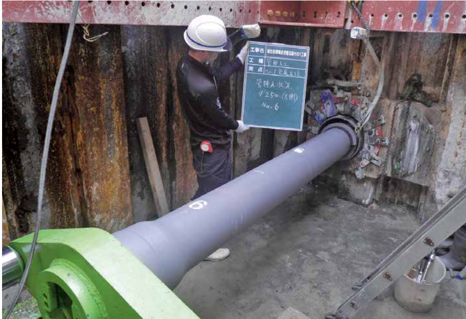
米子市下水道部 (鳥取県) GX形 呼び径 250
