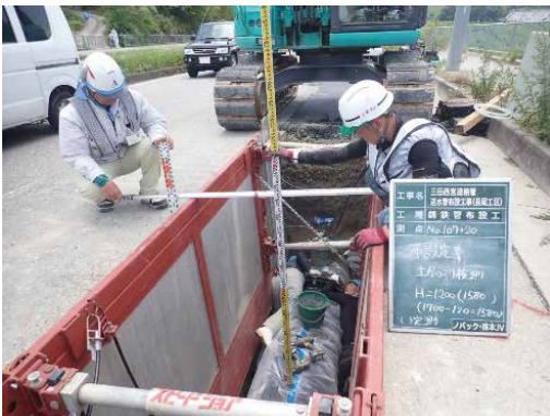
写真 2 長尾工区開削工その 2
