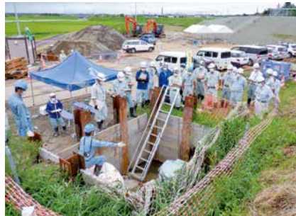
不断水施工現場研修
