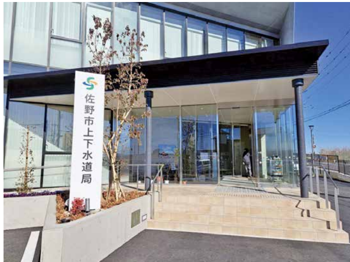
佐野市新上下水道庁舎 正面玄関
