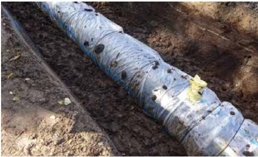
写真2 ポリエチレンスリーブ被覆状況
