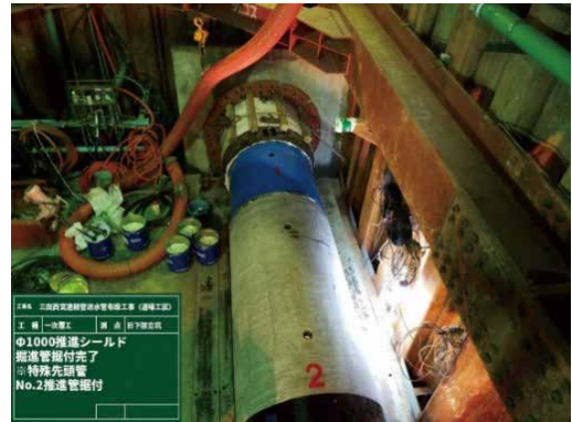
写真 4 道場工区シールド工その 2
