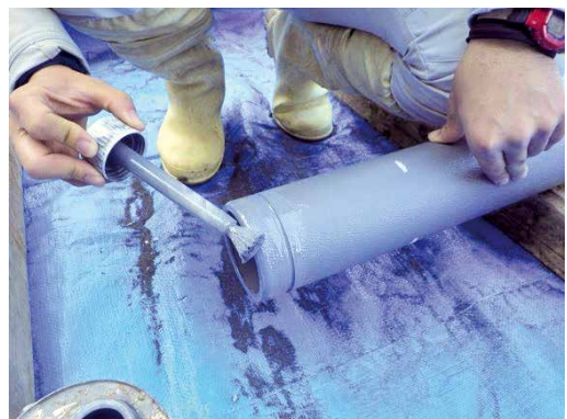
写真3 ダクタイトイル鉄管切管鉄部用塗料の塗布
