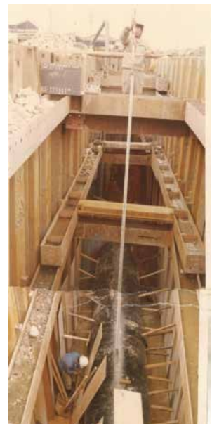
写真4 既設送水管 (昭和51年布設)
