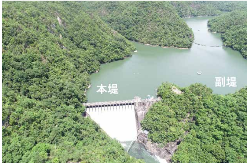
写真5 千苅ダム 全景
