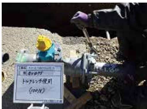
写真4 嵐山仕様の仕切弁とトルク管理
