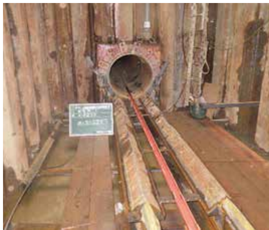
写真4 挿入設備設置状況
