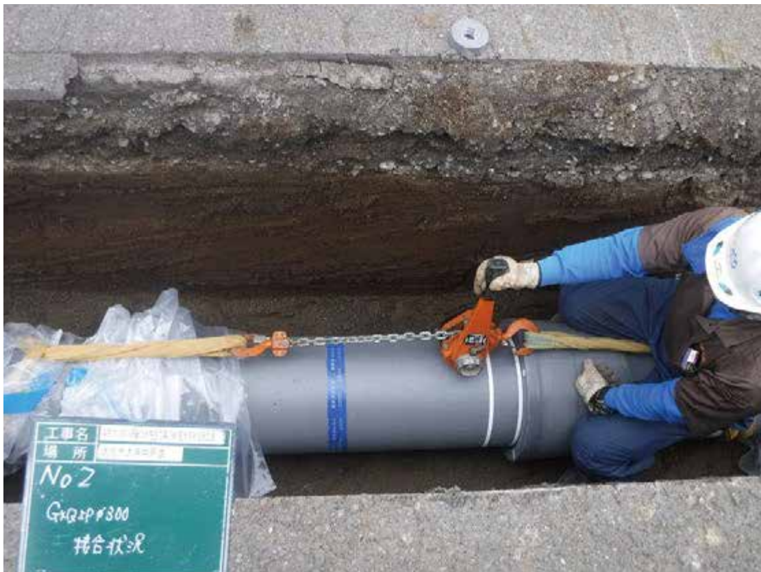
大分市上下水道局 GX形 呼び径 300
