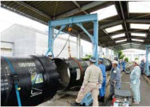
工事業者の研修
