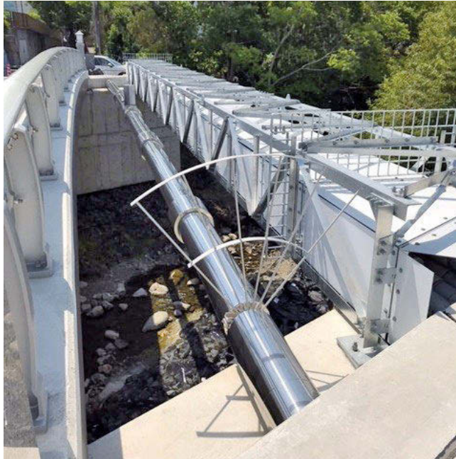
川西市上下水道局（兵庫県） FGX形 呼び径 150（保温材付き）
