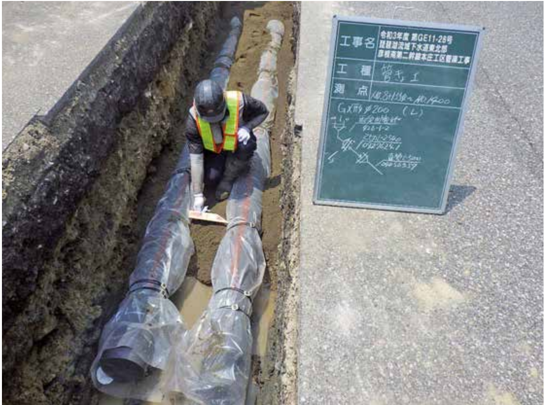
滋賀県北部流域下水道事務所 GX形 呼び径 200
