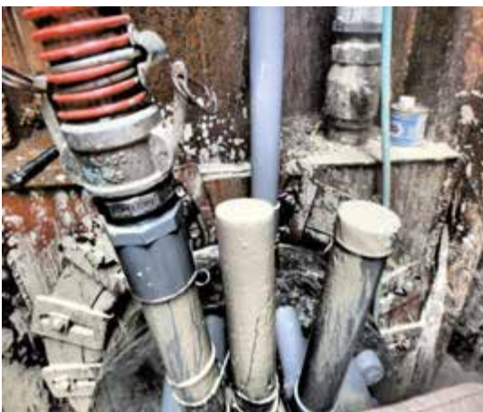
写真9 中詰め注入状況②
