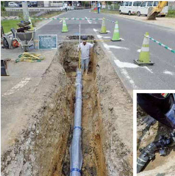
写真1 工事の様子①
