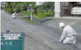
写真2 現場測量状況
