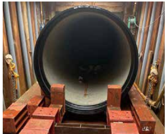
写真5 管挿入状況
