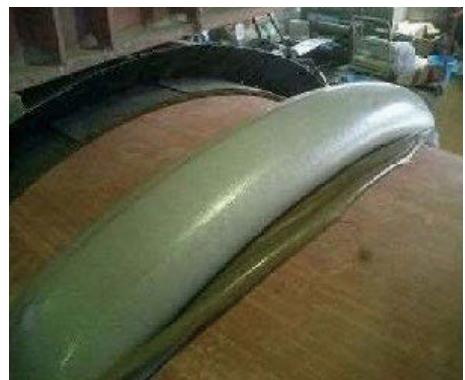
写真6 袋付きセグメントの設置例
