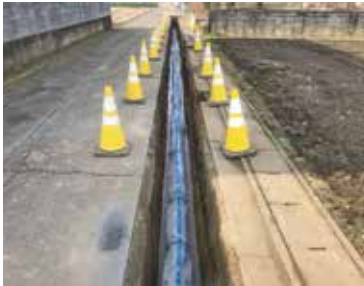
GX 形ダクタイル鉄管も使用
