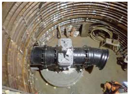
写真15 No.2 中間立坑部配管状況
