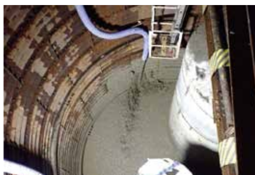
写真19 流動化処理土埋戻状況
