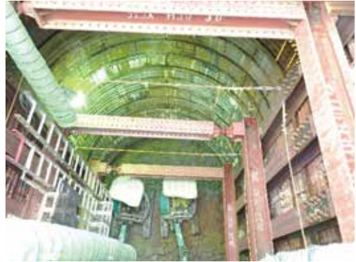
写真11 No.3 中間立坑掘削状況
