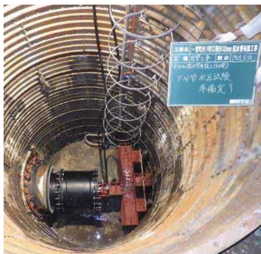
写真 10 水圧試験時の栓止め状況(到達立坑側)
