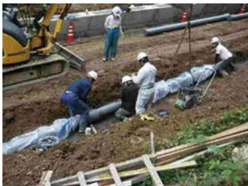
写真9 本設管施工状況(接合)
