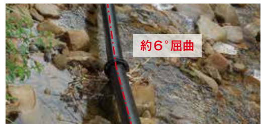
写真3 許容曲げ角度を超過した継手
