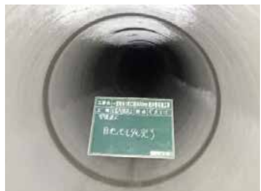
写真2 一次覆工目地詰め後
