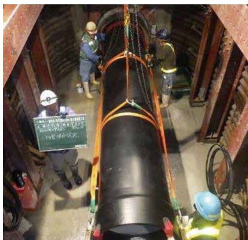
写真 7 PN 形接合状況 1(管挿入)
