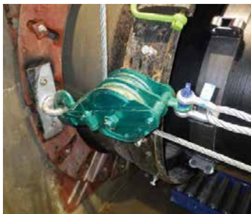
写真 6 坑口側滑車状況
