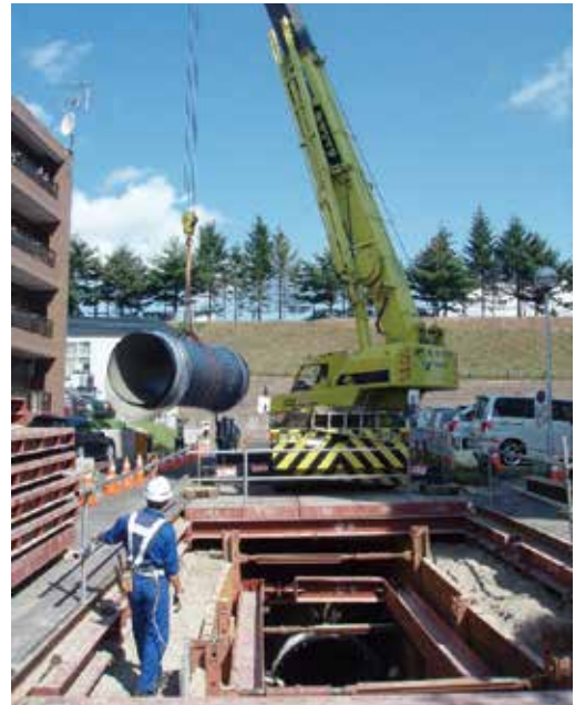
写真2 管吊おろし状況
