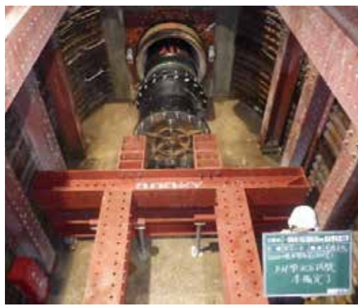
写真 9 水圧試験時の栓止め状況(発進立坑側)
