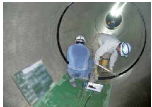
写真9 管接合状況
