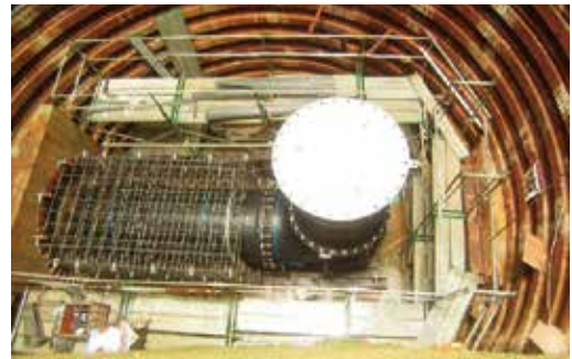
写真4 立坑内配管状況
