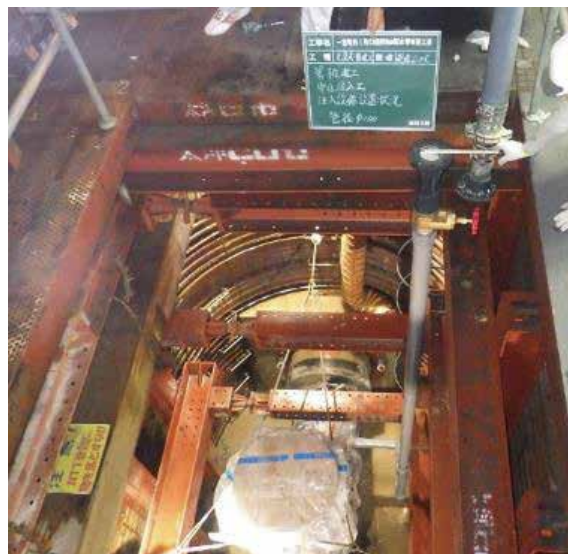
写真 14 中込充填用配管設置状況
