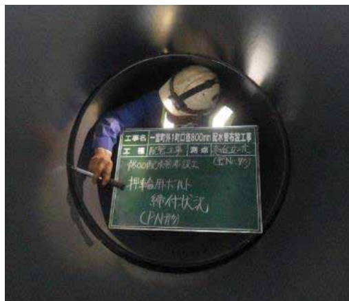
写真 8 PN 形接合状況 2(ボルト締付け)
