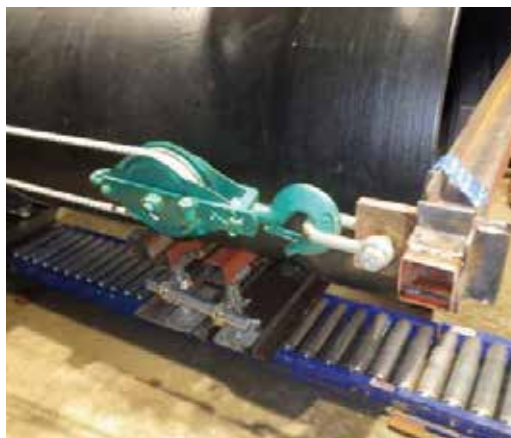
写真 5 PN 形受口側滑車状況
