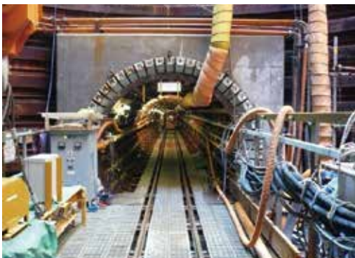
写真6 シールド工法 (豊平川横断工区)
