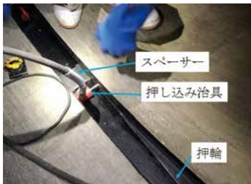
写真5 配管接合状況
