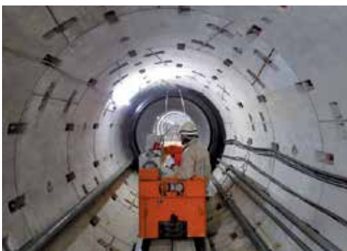
写真8 管運搬状況
