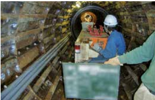
写真3 管運搬状況
