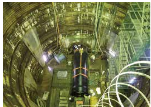
写真7 管吊おろし状況 (立坑内)
