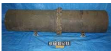
図20 53年間使用された管の外観状況
